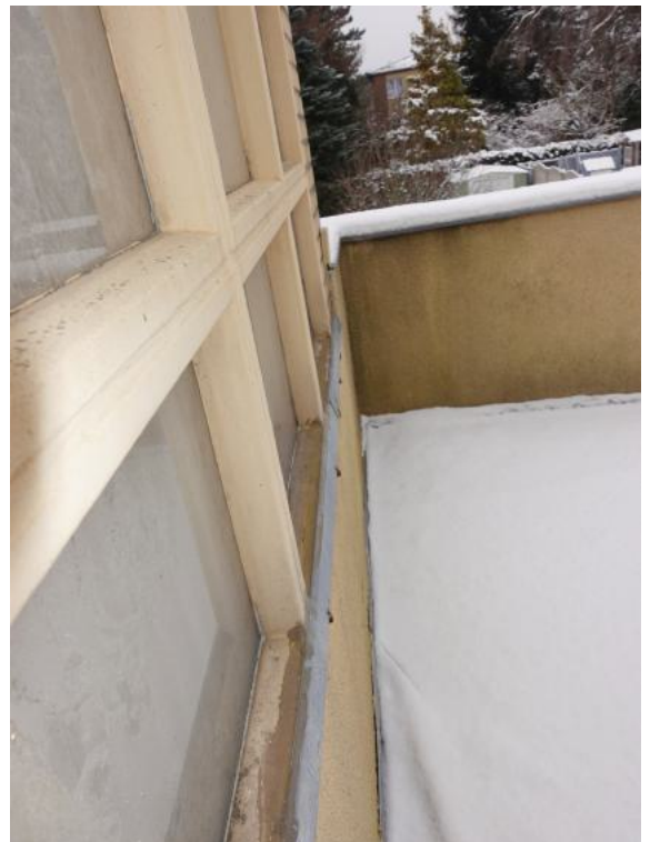
Balkon und Außenwand des "Wintergartens"
