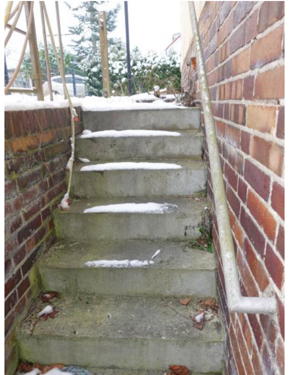
Außentreppe zum Kellergeschoss
