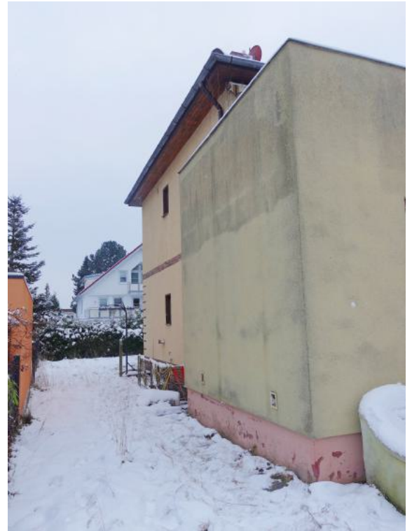
Nordfassade und seitlicher Grenzabstand, Blick zur Straße
