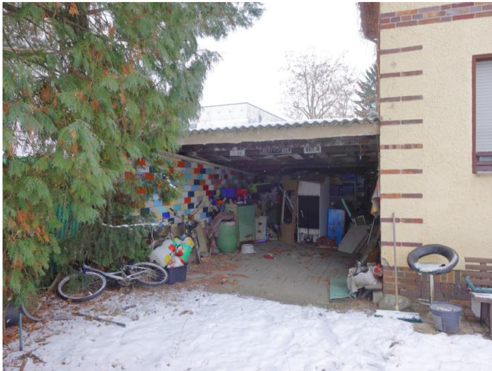
Anbau des Carports
