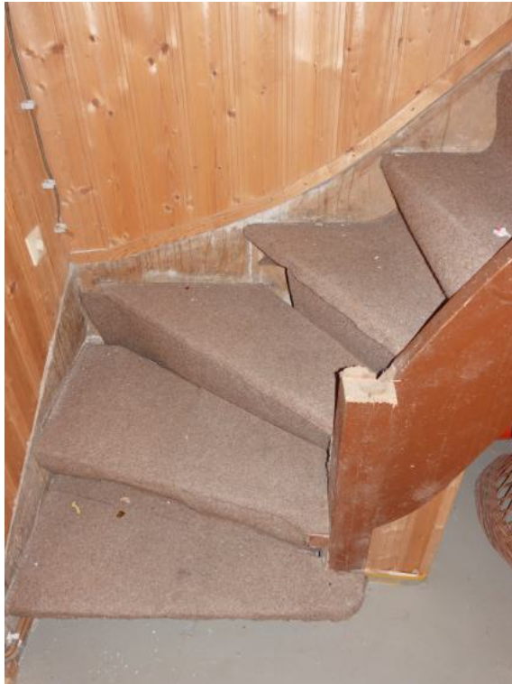
Treppe vom EG zum KG
