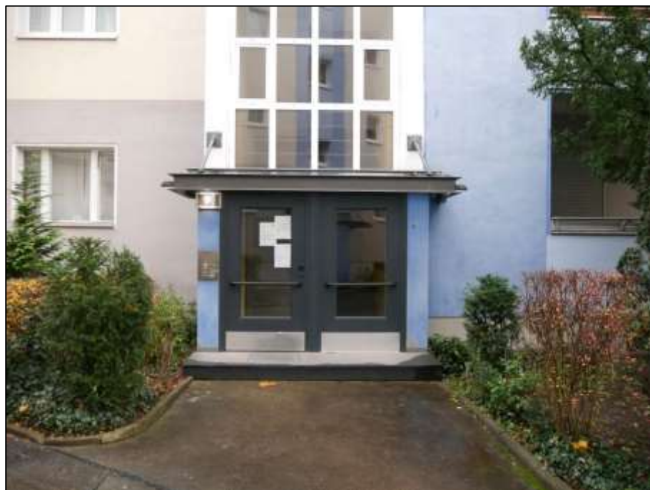
Blick aus dem Bereich der PKW-Stellplatzzufahrt in den Hof des Anwesens und der Hauszuwegung auf den in der freien Giebelseite des Gebäudeteils Johann-Sigismund-Str. 9 belegenen Hauseingang zum Treppenhaus mit Lage der ETW Nr. 34 im 1.OG (links im Bild)
