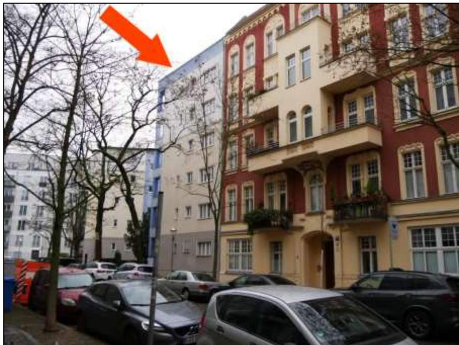
Blick über die Johann-Sigismund-Straße nach Westen mit Lage des Gebäudeteils Johann-Sigismund-Str. 9 auf der nord-westlichen bzw. im Bild rechten Straßenseite (Pfeil)
