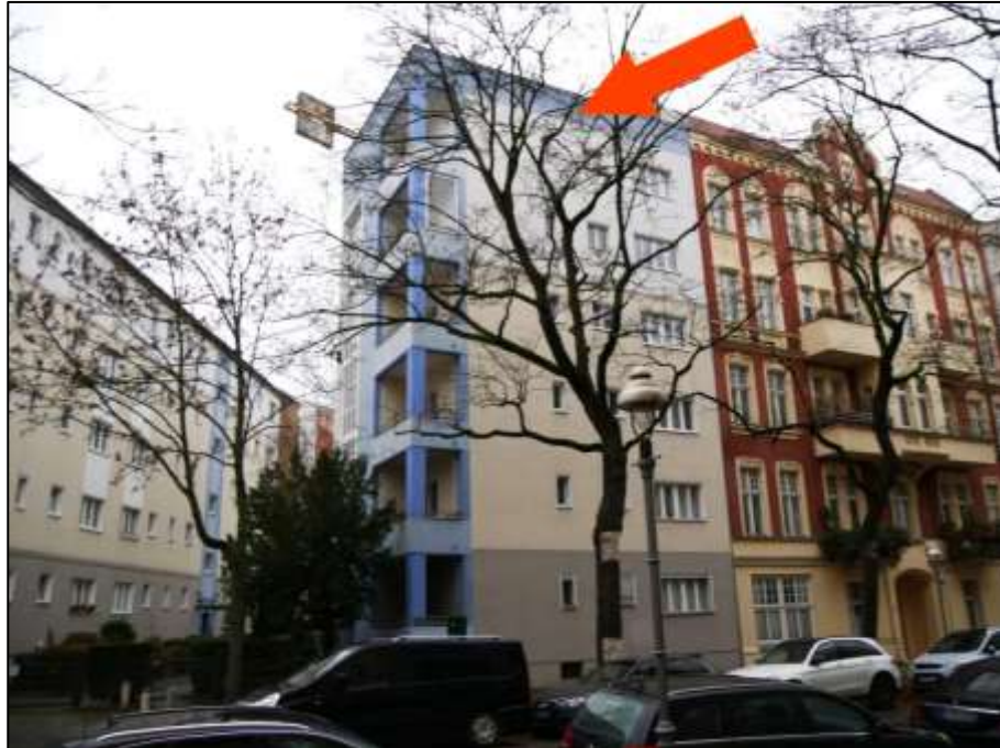
Blick über die Johann-Sigismund-Straße nach Nord-Westen mit Lage des Gebäudeteils Johann-Sigismund-Str. 9 auf der nord-westlichen Straßenseite (Pfeil)
