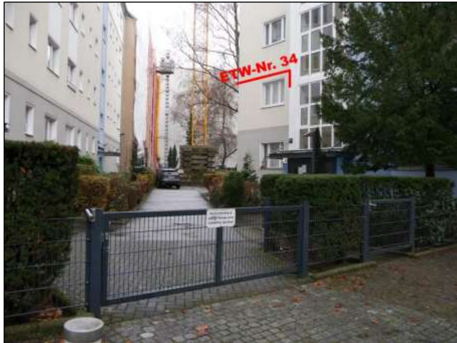
Blick aus der Johann-Sigismund-Straße auf die Grundstückszufahrt in der Zäsur zwischen den Gebäudeteilen Seesener Str. 25, 25A links und dem Gebäudeteil Johann-Sigismund-Str. 9 rechts im Bild und Lage des Wohnungseigentums Nr. 34 im 1. Obergeschoss des Gebäudeteils Johann-Sigismund-Str. 9
