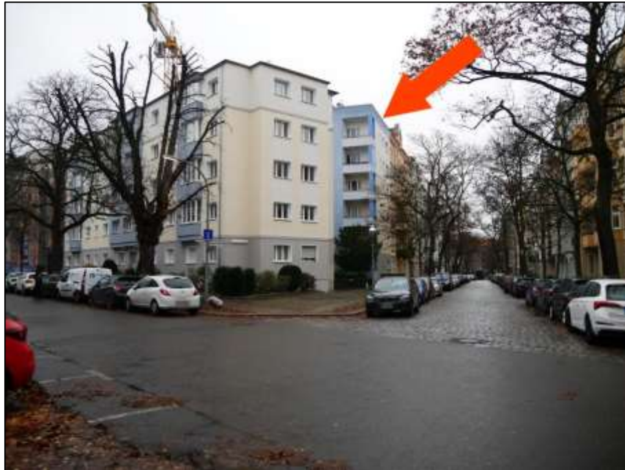
Blick aus dem Einmündungsbereich der Johann-Sigismund-Straße in die Seesener Straße nach Norden auf das Grundstück Seesener Straße 25, 25A, Johann-Sigismund-Str. 9 mit Lage des Gebäudeteils Johann-Sigismund-Str. 9 (Pfeil)
