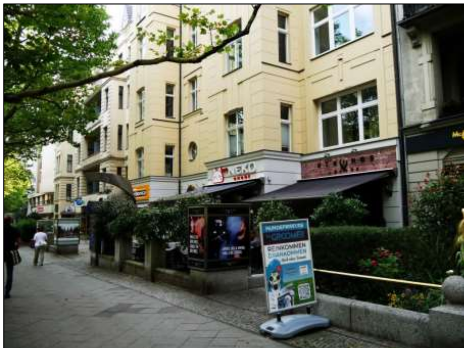
Straßenraum vor dem hier betroffenen Grundstück Kurfürstendamm 132A mit befestigter ehemaliger Vorgartenfläche (nunmehr öffentlicher Straßenraum) und Einfriedung der Schankgartenfläche des ansässigen Gastronomiebetriebes
