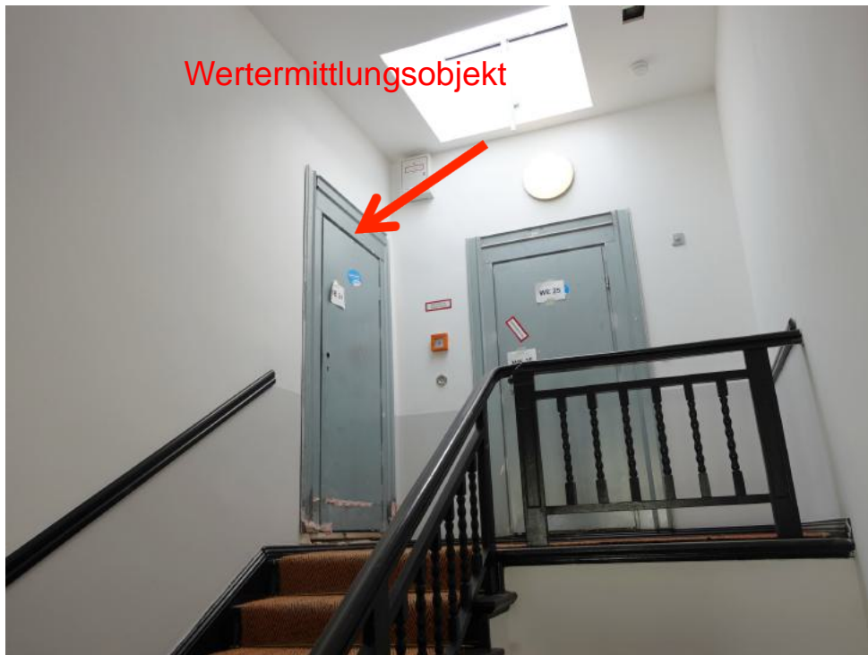
Oberster Treppenabsatz mit der Wohnungseingangstür der WE 24
