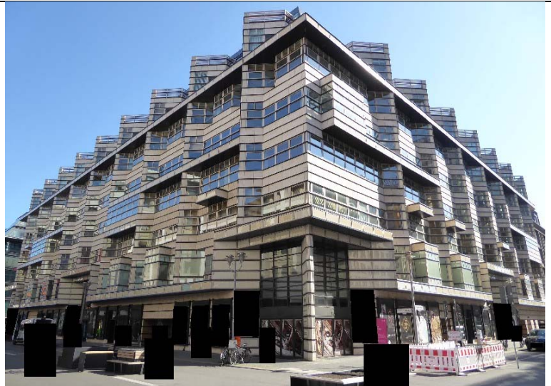
8-geschossiges, unterkellertes Wohn- und Geschäftshaus; 4 Geschosse liegen unterirdisch, 8 Geschosse liegen oberirdisch
