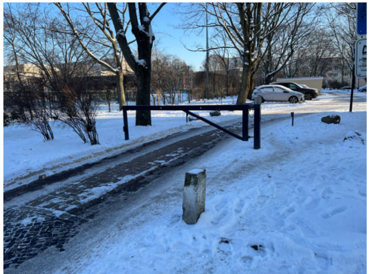
- Detail: Keller und Zufahrt auf den Hofbereich -
