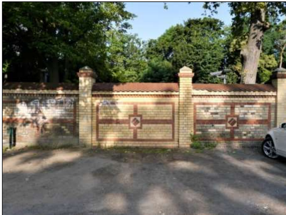
Blick auf den Bereich der Grundstücksmaske zur Spreetalallee vor der Mauerwerkseinfriedung des Grundstücks mit bereits abgesäuerter Teilfläche der Mauerwerkseinfriedung
