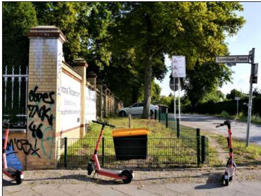
Blick aus dem Spandauer Damm nach Norden auf die zu dem Grundstück gehörende sogen. Grundstücksmaske mit Stabmatteneinfriedung vor dem mit Mauerwerkscheidung umfriedeten Grundstücksfläche und Spreetalallee als unbefestigte Privatstraße rechts im Bild
