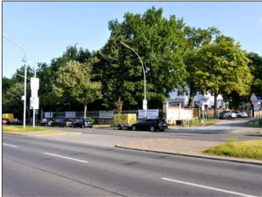
Blick über den Spandauer Damm nach Norden auf das Eckgrundstück Spreetalallee 1, Spandauer Damm 212 (Flurstück 676) auf der nord-östlichen Straßenseite mit Lage des aufstehenden Wohn- und Geschäftshauses und anbindender Spreetalallee rechts im Bild
