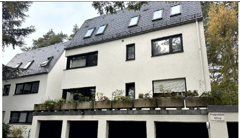
2-geschossiges, unterkellertes Mehrfamilienhaus mit ausgebautem Dachgeschoss, freistehend
