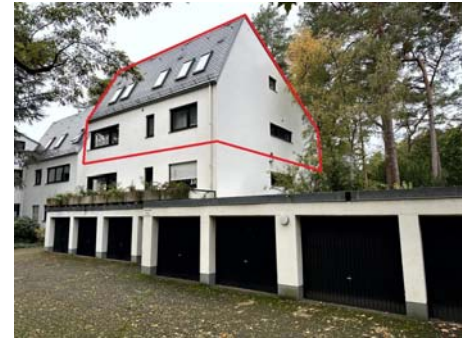
Straßenansicht mit Kennzeichnung Sondereigentum Nr. 11 im 1. OG/DG
