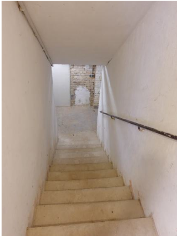
Treppe vom EG zum Kellergeschoss
