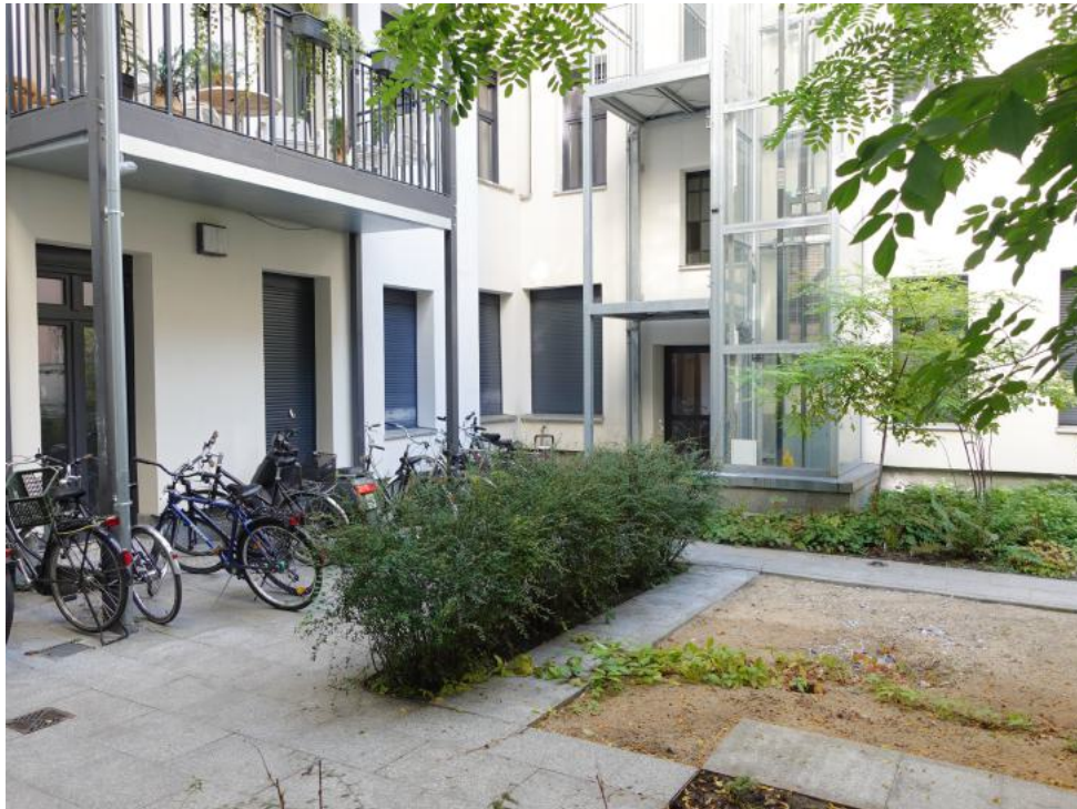
Innenhof, Blick auf den Seitenflügel (links) und die Hoffassade Vorderhaus (rechts)
