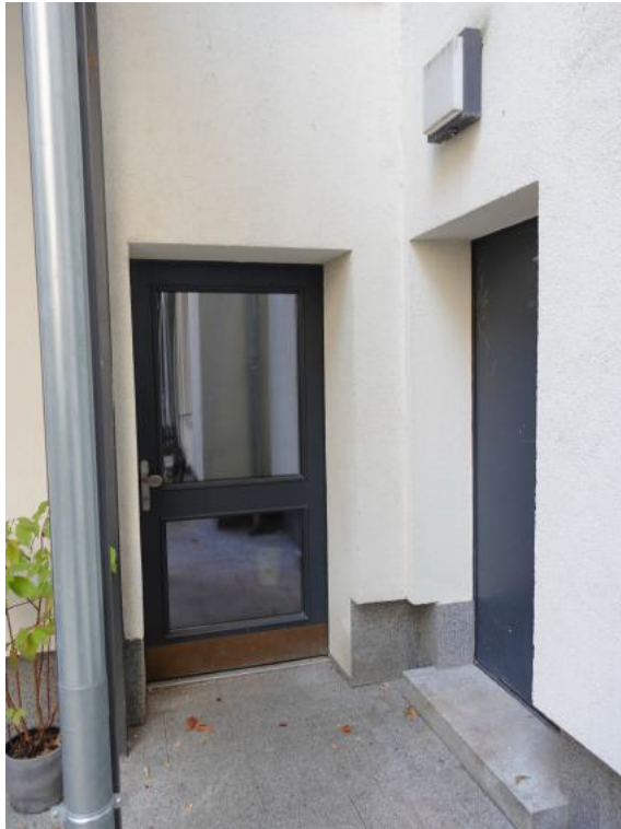
Hauseingang zum Hinterhaus vom Innenhof.
