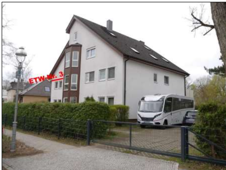
Blick aus der Fontanestraße nach Süd-Osten auf die zum rechten Bauwich orientierte Gebäudefront sowie die nord-östliche Giebelseite als Hauseingangsfront des auf dem Grundstück Fontanestr. 1 aufstehenden Wohngebäudes mit Lage der ETW-Nr. 3 im 1. Obergeschoss
