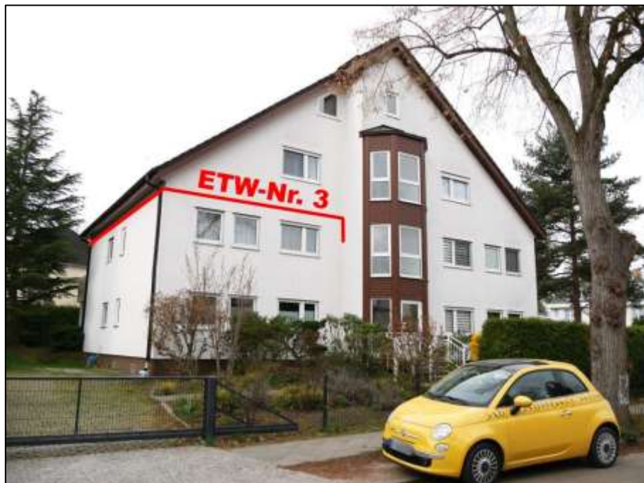
Blick aus der Fontanestraße nach Süd-Westen auf die zum linken Bauwich orientierte Gebäudefront sowie die nord-östliche Giebelseite als Hauseingangsfront des Mehrfamilienhauses mit Lage der ETW-Nr. 3 im 1. Obergeschoss
