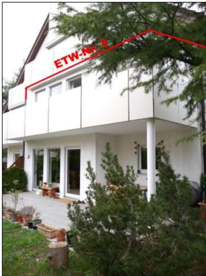
süd-westliche Front des auf dem Grundstück Fontanestr. 1 aufstehenden Mehrfamilienwohnhauses mit Lage der ETW-Nr. 3 im 1.OG mit Balkon oberhalb der im EG belegenen Gartenterrasse
