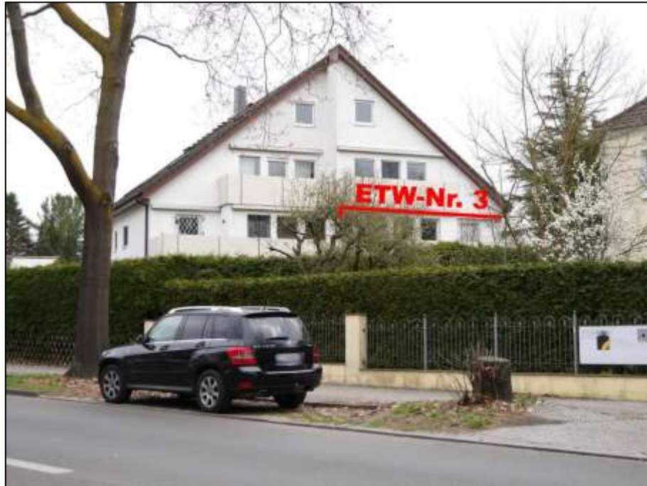
Blick aus der Berliner Straße nach Nord-Osten auf die süd-westliche Giebelseite des auf dem Grundstück Fontanestr. 1 aufstehenden Mehrfamilienhauses mit Lage der ETW-Nr. 3 im 1. Obergeschoss
