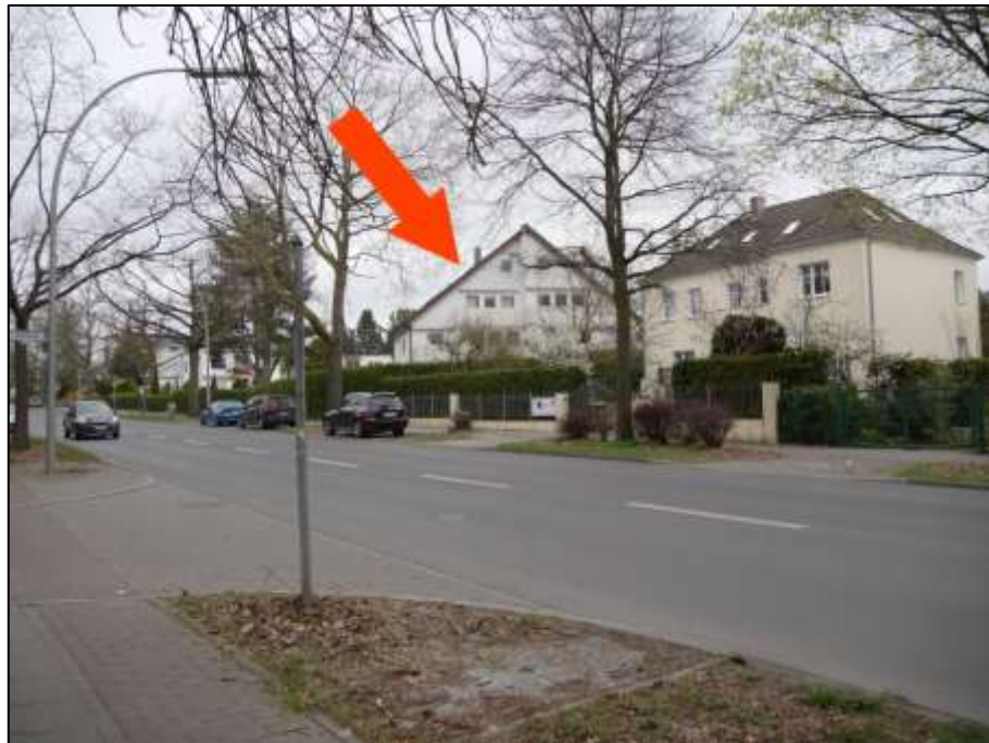
Blick über die Berliner Straße nach Nord-Osten mit Lage des auf dem Grundstück Fontanestr. 1 aufstehenden Mehrfamilienhauses auf der im Bild rechten bzw. östlichen Seite der Berliner Straße (Pfeil)
