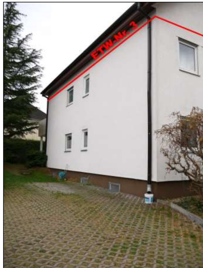
zum linken Bauwich orien- tierte Gebäude- front des auf dem Grund- stück Fontane- str. 1 aufste- henden Mehr- familienhauses mit Lage der ETW-Nr. 1 im 1.OG
