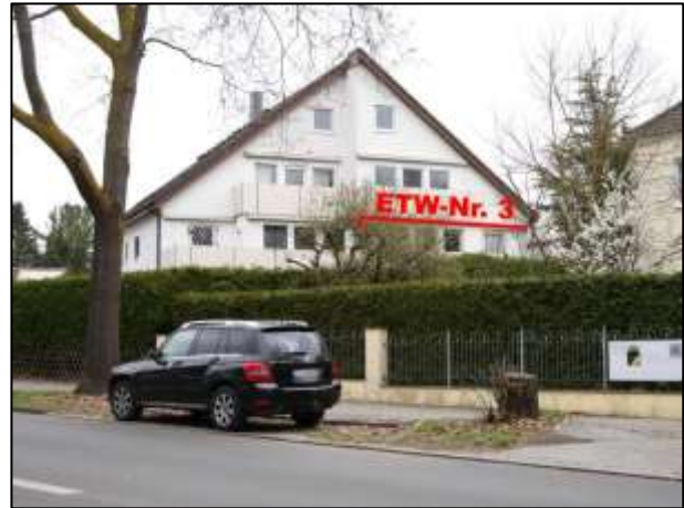
Blick a.d. Berliner Straße - WE-Nr. 3 im 1.OG
