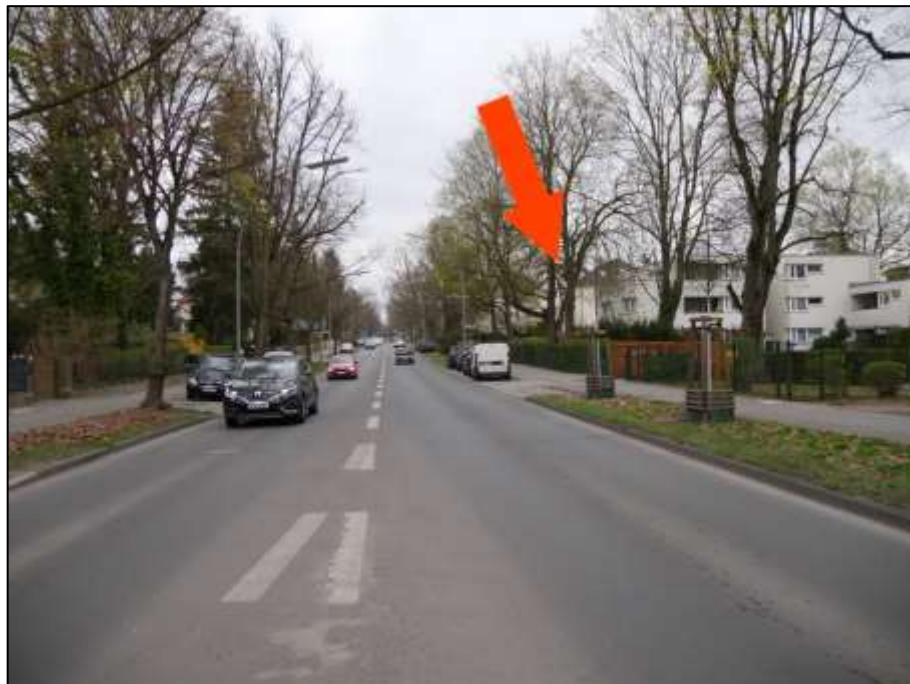
Blick in die Berliner Straße nach Norden mit Lage des auf dem Grundstück Fontanestr. 1 aufstehenden Mehrfamilienhauses auf der östlichen bzw. im Bild rechten Seite der Berliner Straße (Pfeil)
