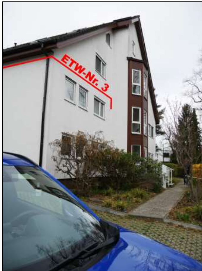
straßenseitige Hauseingangs- front des auf dem Grundstück Fontanestr. 1 aufstehenden Mehrfamilien- hauses mit Lage der ETW-Nr. 1 im 1.OG
