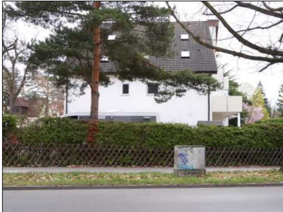
Blick aus der Berliner Straße nach Süd-Osten auf die zum rechten Bauwich orientierte Front des auf dem Grundstück Fontanestr. 1 aufstehenden Mehrfamilienhauses
