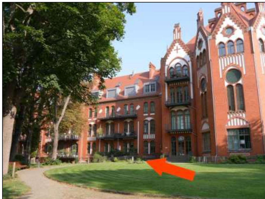
Blick durch den Torzugang in der straßenseitigen Einfriedung des Grundstücks Mollwitzstr. 11, 12, 13 u.a. (Flurstück 1239) auf das Hinter- liegergrundstück Mollwitzstraße 11, 12 (Flurstück 1235) mit dem Gebäu- deteil Mollwitzstr. 12 und Lage des Teileigentums E.0.1 im UG (Pfeil)
