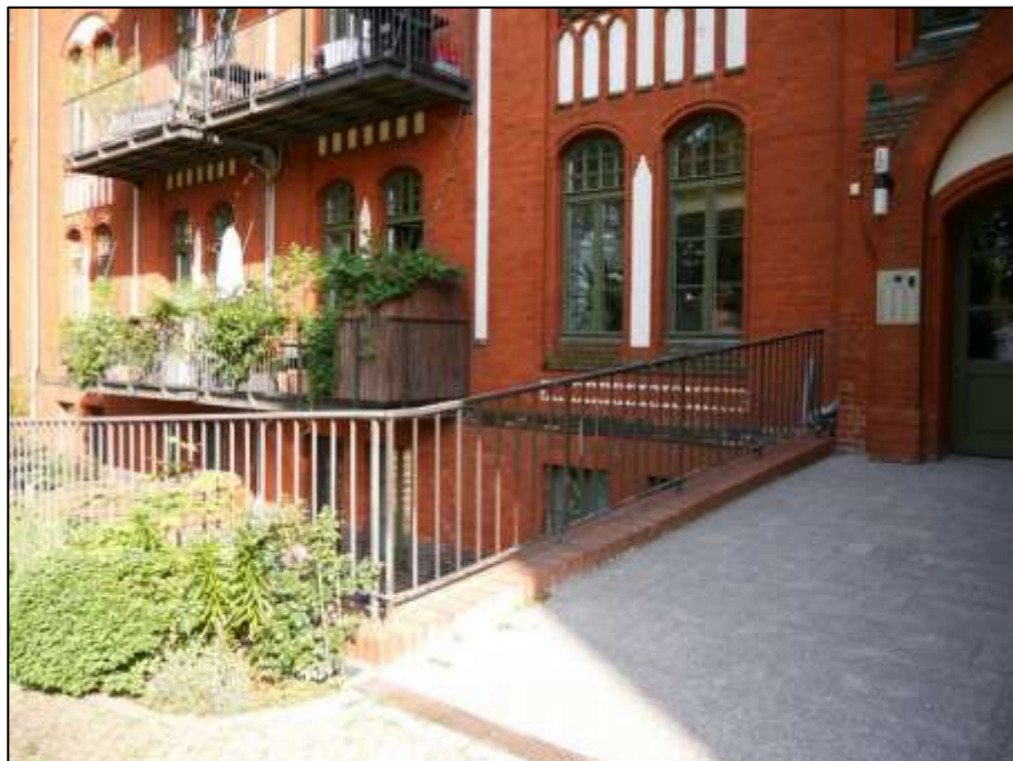
Lage des Teileigentums Nr. E.0.1 im Untergeschoss als sogen. Gartengeschoss mit anbindender Gartenterrasse als SNR E.0.1 unmittelbar unterhalb der Brüstung der Zugangsrampe des Treppeneingangs im Gebäudeteil Mollwitzstr. 12
