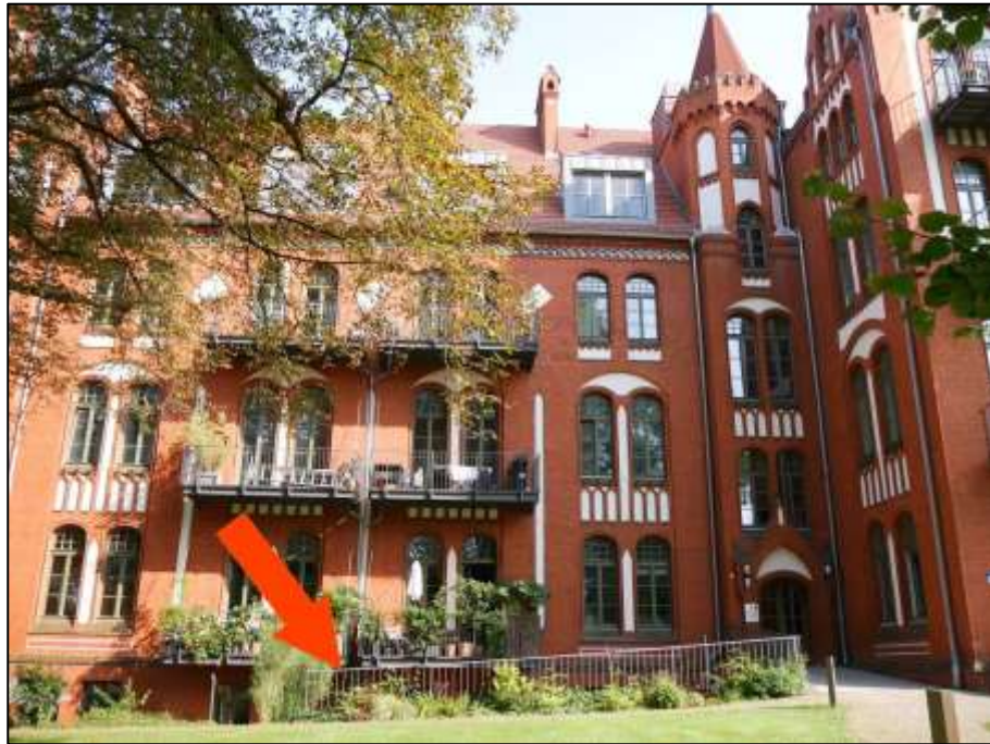
Hinterliegergrundstück Mollwitzstraße 11, 12 (Flurstück 1235) im Bereich des Gebäudeteils Mollwitzstr. 12 mit Lage des Teileigentums Nr. E.0.1 im Untergeschoss als sogen. Gartengeschoss (Pfeil)
