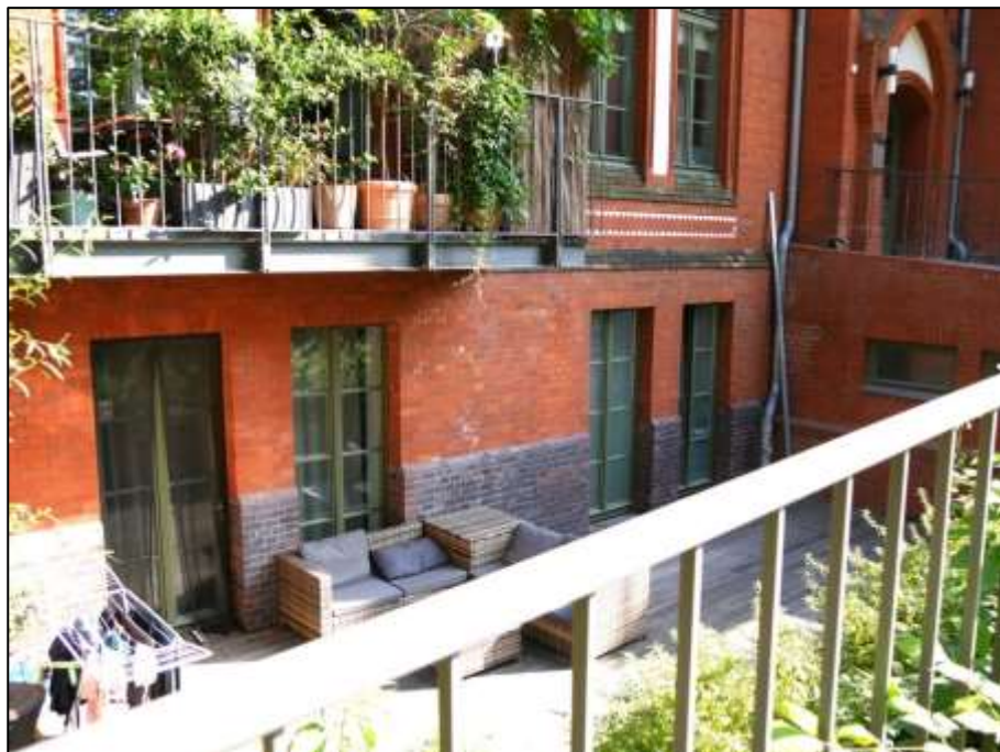
Blick über die Brüstung der oberhalb der Stützmauer zum höher liegenden Gelände des Grundstückes auf das Teileigentum Nr. E.0.1 im Untergeschoss als sogen. Gartengeschoss mit davor belegener anbindender Gartenterrasse als SNR E.0.1
