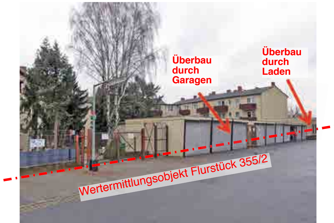
Blick nach Nord-West auf das Wertermittlungsobjekt, Überbau vom Grundstück 356/2
