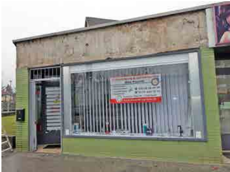
Gewerbe - Sanitärservice, Straßenfront
