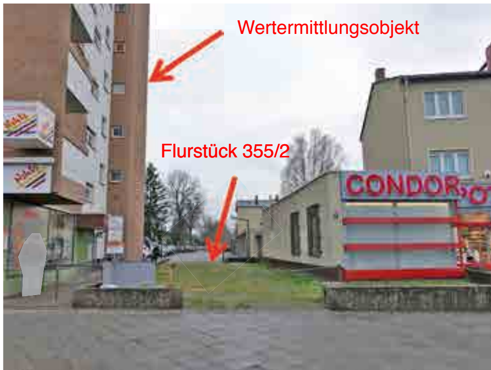
Blick von der Neuköllner Straße Richtung Süden auf das Flurstück 355/2
