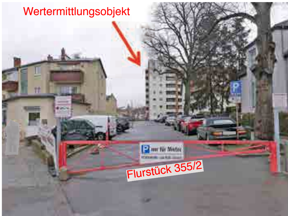
Blick nach Norden zur Neuköllner Straße auf das Flurstück 355/2
