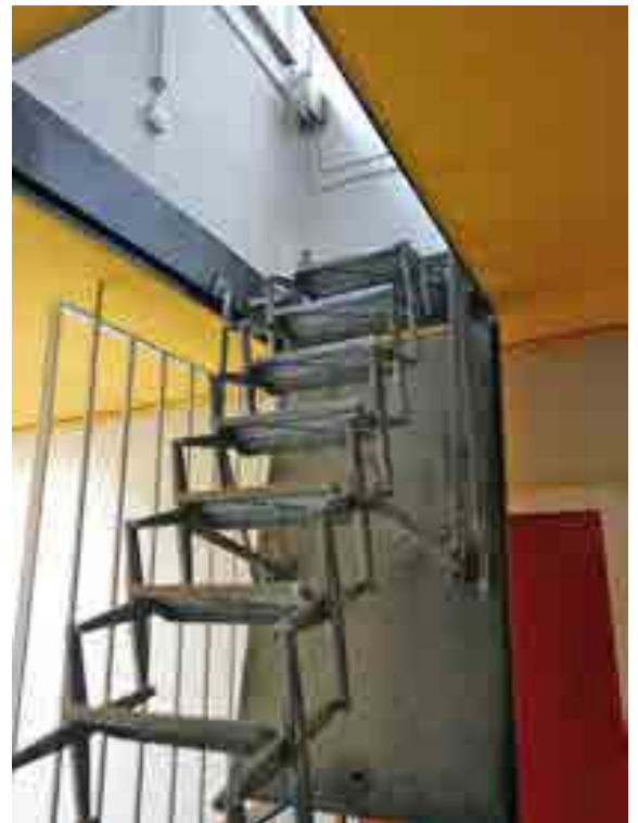
Auszugtreppe zum Dach
