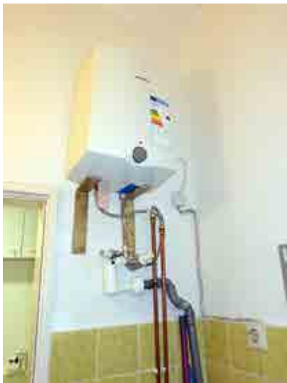
Detail Warmwasserbereitung
