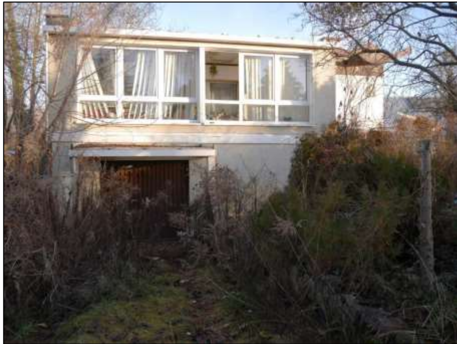
straßenseitige Front des auf dem Grundstück Wilhelmsruher Damm 8D aufstehenden Einfamilienhauses als Bungalow (Typ HP1) mit Rampe zur Kellergarage u.a. im Bereich des unterkellerten Wintergarten-Vorbaus
