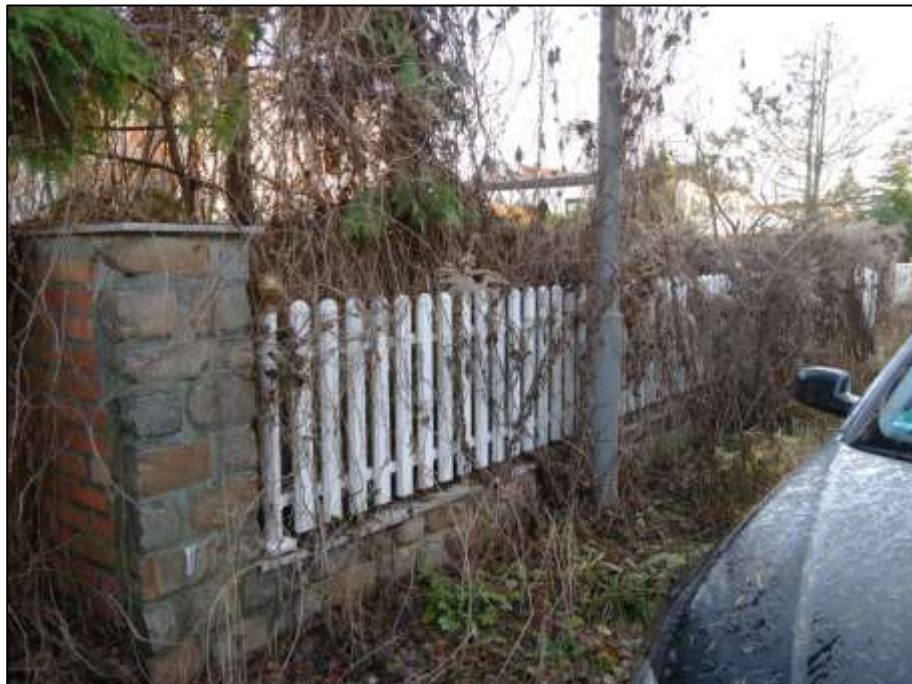
straßenseitige Einfriedung mit Sockel nebst aufgesatteltem Staketenzaun und Pfeilern aus Straßenpflaster-Granit
