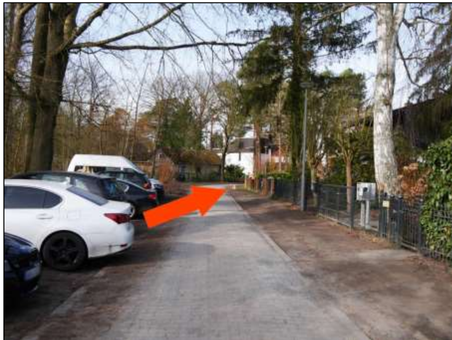
Blick in die Rabenstraße nach Westen mit Lage des Grundstücks Rabenstr. 33A, 33B auf der nördlichen bzw. im Bild rechten Straßenseite (Pfeil)
