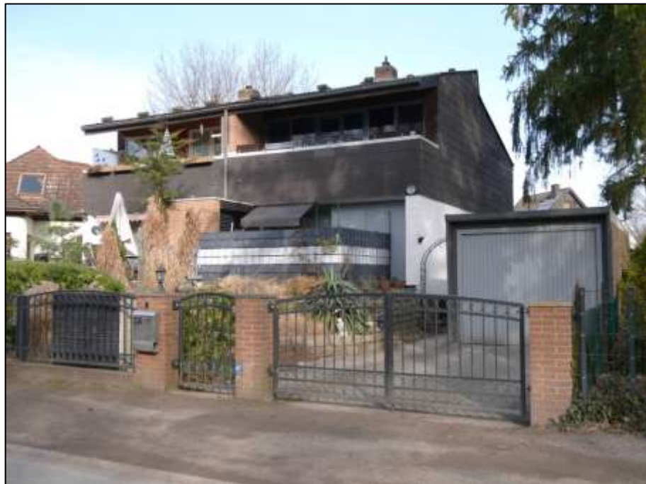
Blick über die Rabenstraße nach Nord-Westen auf die straßenseitige Front des Grundstücks Rabenstr. 33A, 33B mit aufstehendem Zweifamilien-Doppelhaus bzw. aufstehenden Einfamilien-Doppelhaushälften - rechts im Bild ETW-Nrn. 2+4 als DHH nebst Garage Nr. 4 vorne rechts
