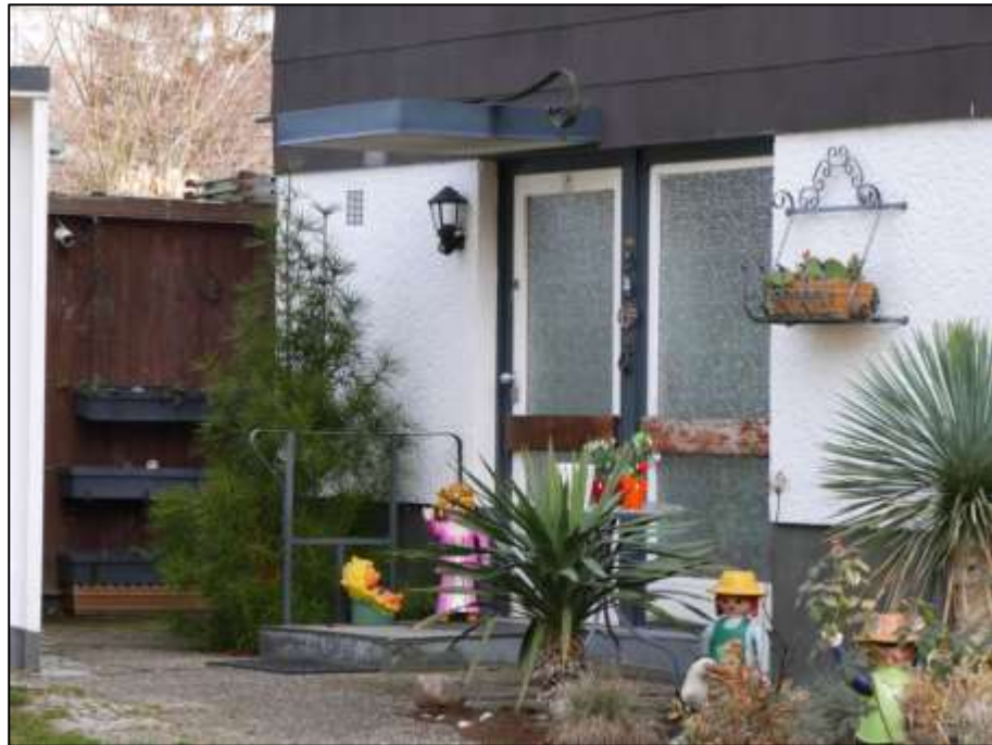
freie Giebelseite als Hauseingangsfront der linken bzw. westlichen Einfamilien-Doppelhaushälfte als ETW-Nr. 1+3 im Bereich der Hauseingangstür mit an die Hauseingangstür angrenzendem bodentiefem Fenster der Essdiele in demselben Charakter wie die Hauseingangstür
