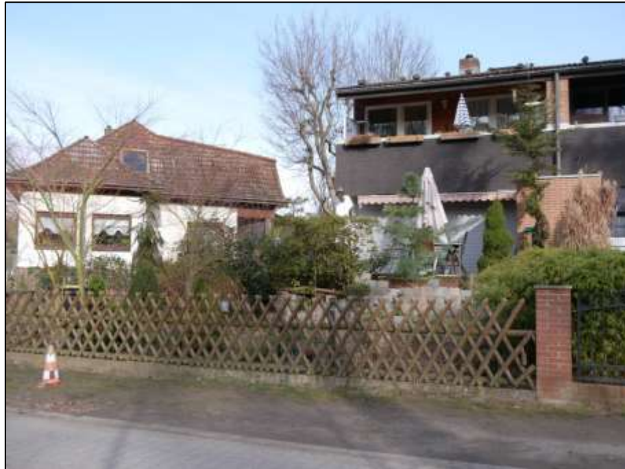
Blick über die Rabenstraße nach Nord-Westen auf die straßenseitige Front des Grundstücks Rabenstr. 33A, 33B im Bereich des Wohnungseigentums Nrn. 1+3 als linke bzw. westliche Einfamilien-doppelhaus-hälfte
