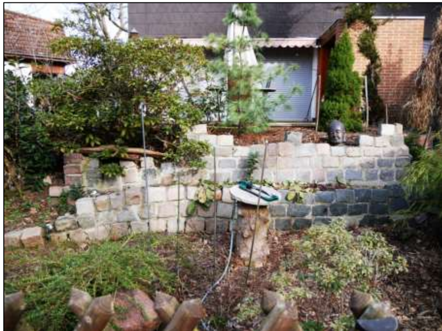
Blick über die straßenseitige Grundstückseinfriedung auf die terrasierte Böschung mit Straßengranit-Stützwänden vor der Terrasse der linken Doppelhaushälfte als ETW-Nrn. 1+3 mit über die Terrasse zugänglicher Abstellkammer rechts im Bild
