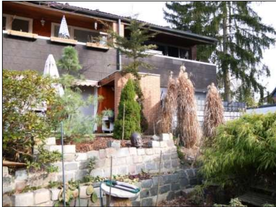
straßenseitige Front des Zweifamilien-Doppelhauses mit hinter der Terrasse vor dem Wohnzimmer im EG der ETW-Nrn. 1+3 anbindender Abstellkammer als Sichtschutz zur benachbarten Terrasse des angrenzenden Wohnungseigentum Nrn. 2+4 als rechte bzw. östliche Einfamilien-Doppelhaushälfte mit dort angrenzender entsprechender Kammer
