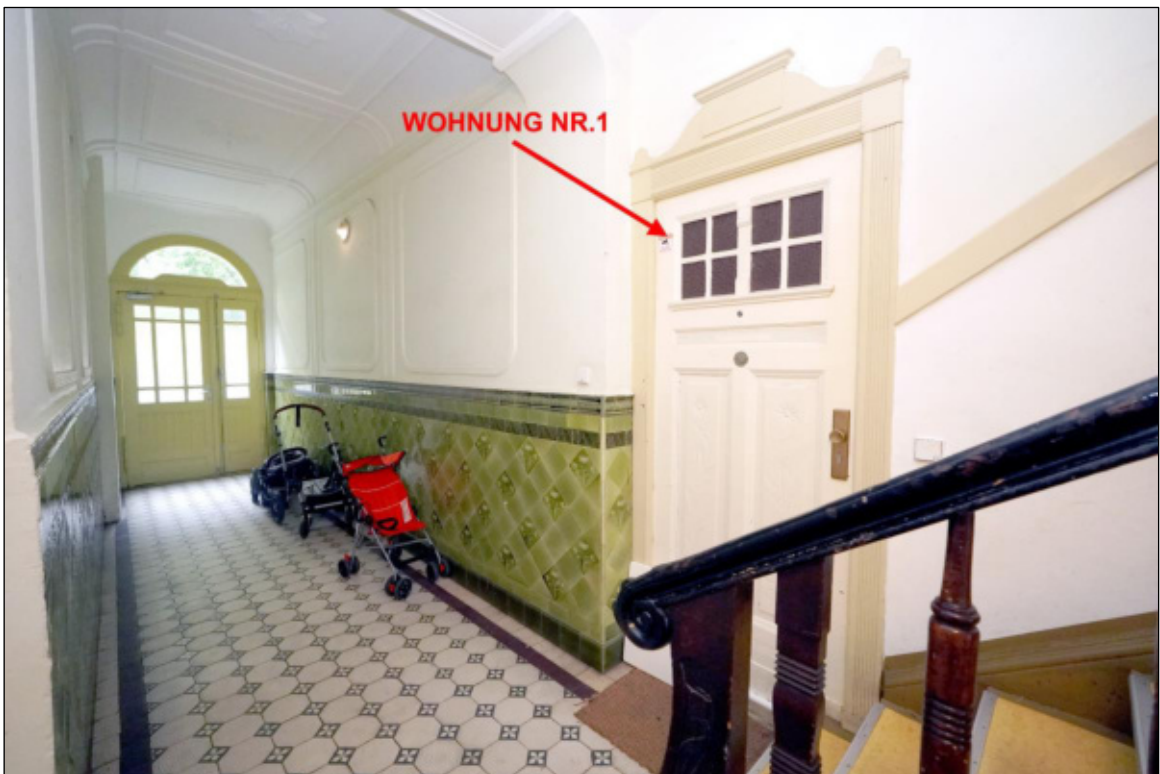
Eingangsbereich des Vorderhauses / Durchgang zum Hof / Wohnungseingangstür
