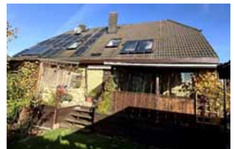
Seitenansicht Doppelhaus, Lavendelweg 33/33 A
