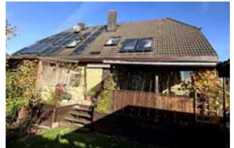
Seitenansicht Doppelhaus, Lavendelweg 33/33 A
