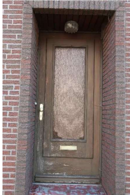
Ansicht Eingangstür Straßenseite
