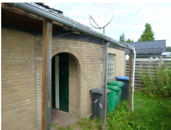
Ansicht Tor zum Durchgang
