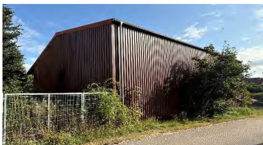
Abbildung 16: Scheune straßenseitig, Blickrichtung Nordosten
