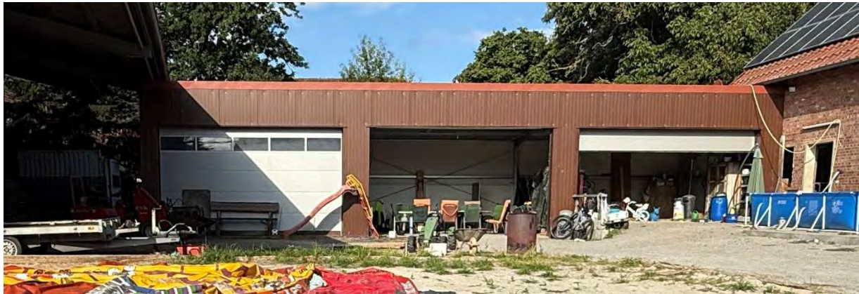
Abbildung 13: Carport hofseitig, Blickrichtung Westen
