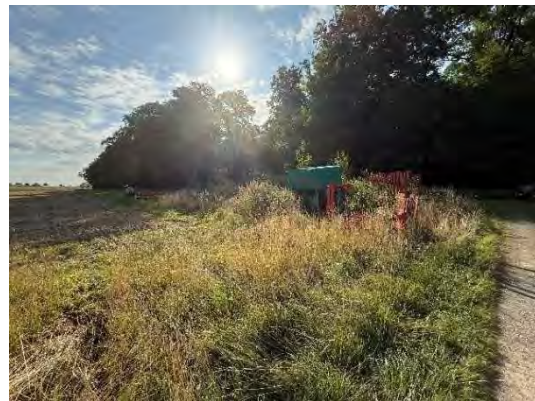
Abbildung 4: FIST 32, südwestlicher Teil mit Maschinen und Bauschutt, Blickrichtung Südosten
