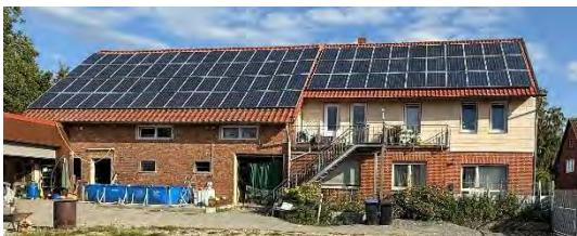
Abbildung 11: Wohnhaus hofseitig, Blickrichtung Norden
