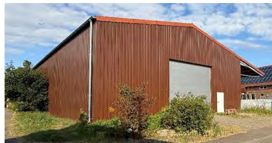
Abbildung 15: Scheune straßenseitig, Blickrichtung Nordwesten
