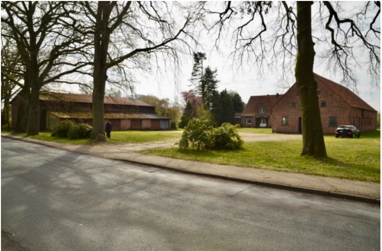
Foto 1 Straßenansicht der ehemaligen Hofstelle von Nordwesten
