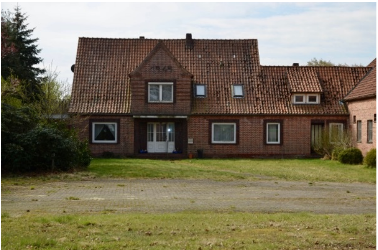
Foto 2 Nordansicht des ehemaligen Wohnhauses mit Zwischenbau (Position 1), rechts Position 2
