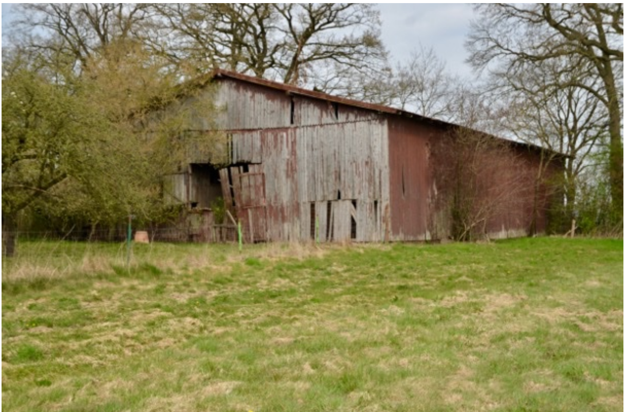
Foto 6 Südostansicht der ehemaligen Scheune (Position 3)
