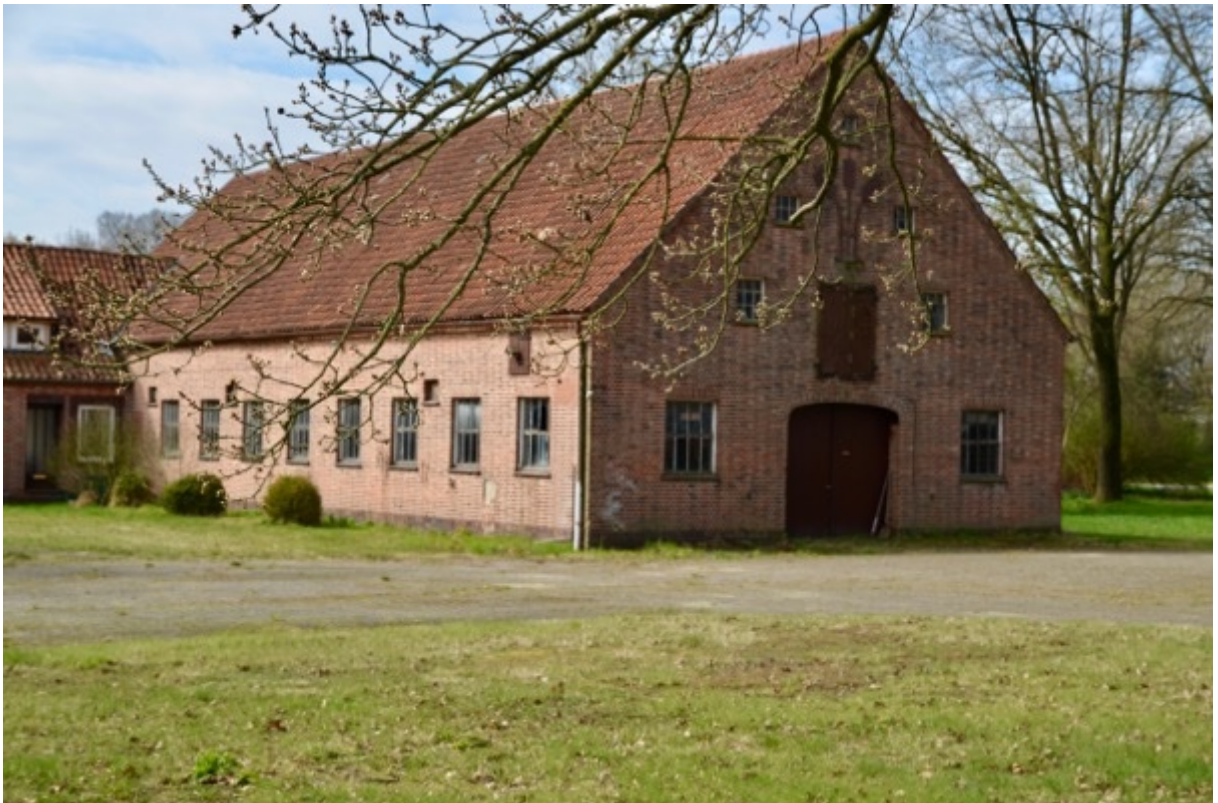
Foto 3 Nordostansicht des ehemaligen Stallgebäudes (Position 2), links Zwischenbau (Position 1)
