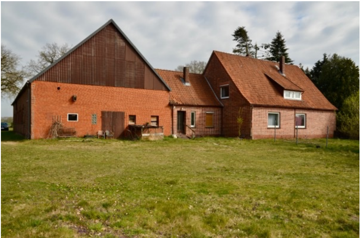
Foto 5 Südwestansicht des ehem. Stallgebäudes Pos. 2 (links) u. Wohnhauses mit Zwi.-bau (Pos. 1)
