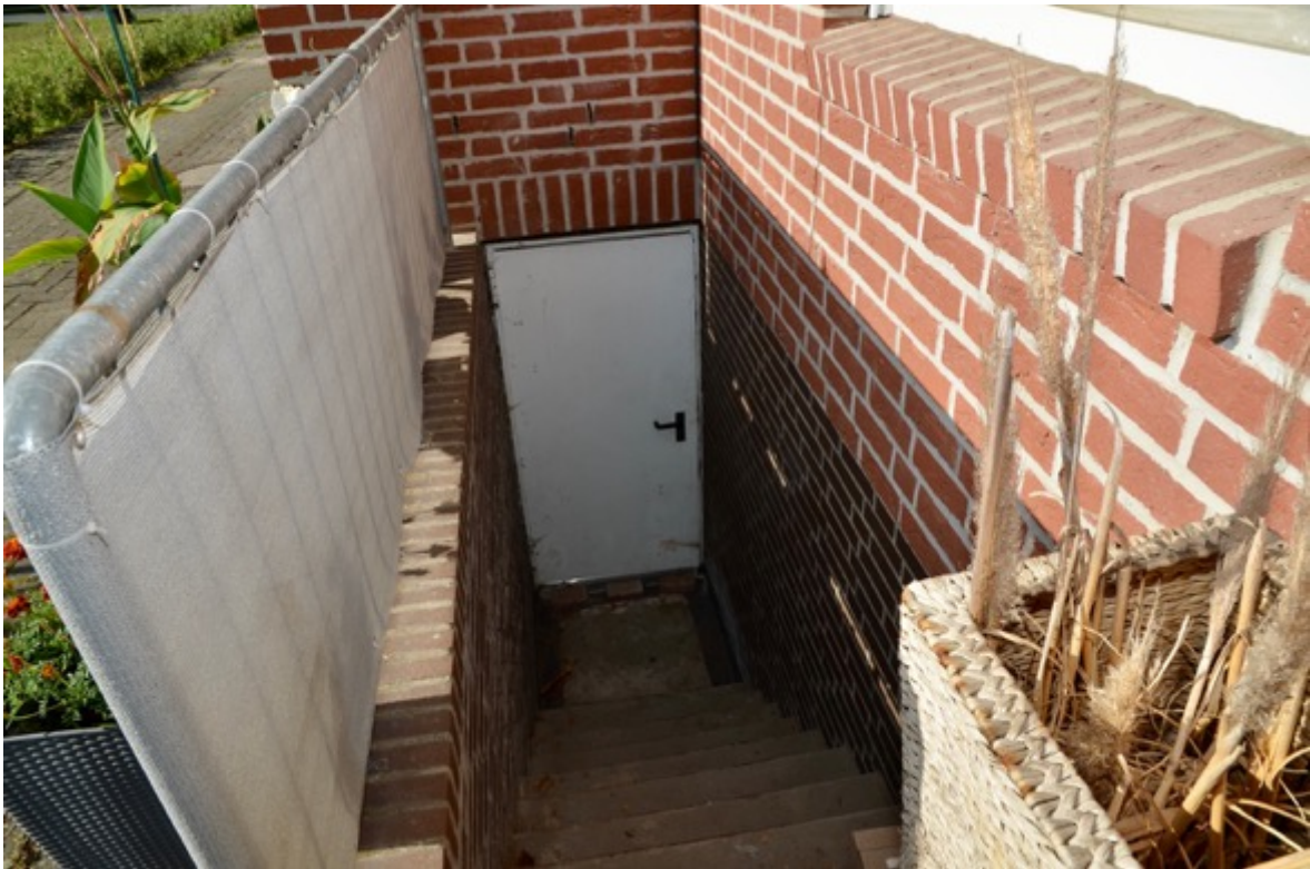
Foto 11 Kelleraußentreppe zum Kellergeschoss des vorderen Wohnhauses
