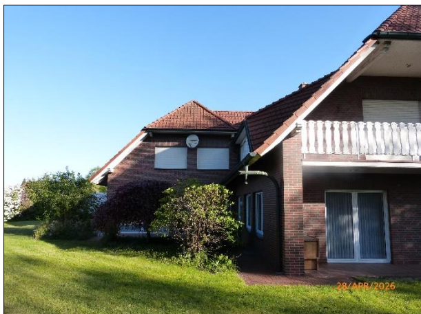
südöstlicher Giebel (Garage. u. Wohnhaus)
