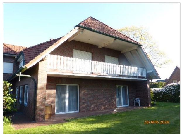
südöstlicher Giebel Wohnhaus
