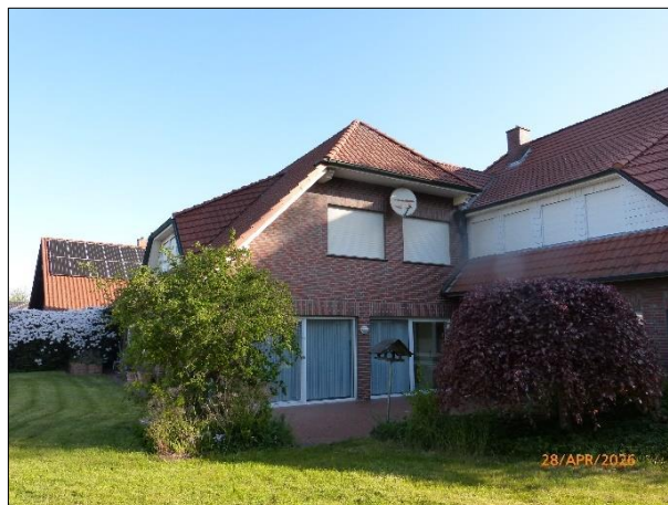
südwestliche Garage Wohnhaus
