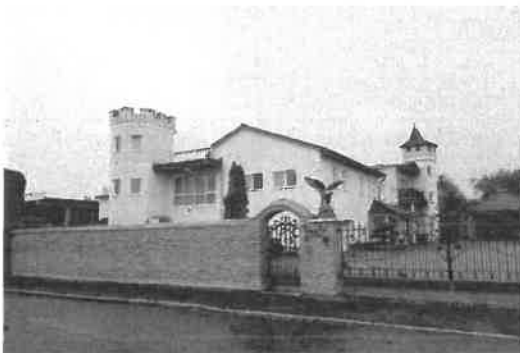
straßenseitige/ zufahrtsseitige Ansicht
