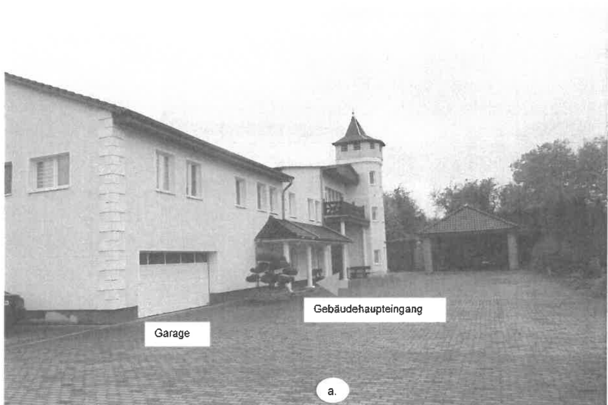
Industriegebäude, Gotthelf- Leimbach- Straße 11 A, gepflasterte Hoffläche, links Industriegebäude, Mitte Carport 1
