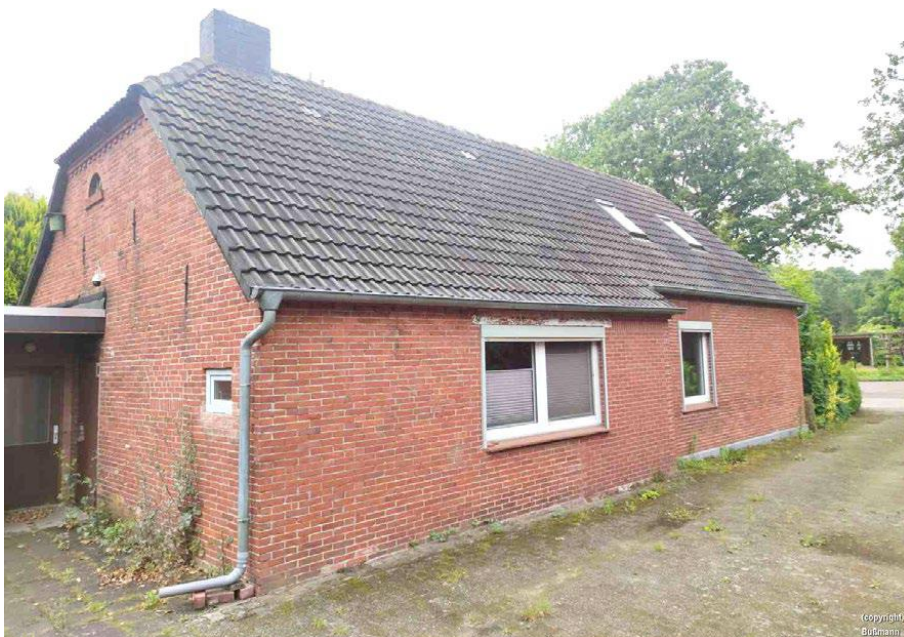
Seitenansicht auf Rückseite Wohnhaus mit Nebeneingang
