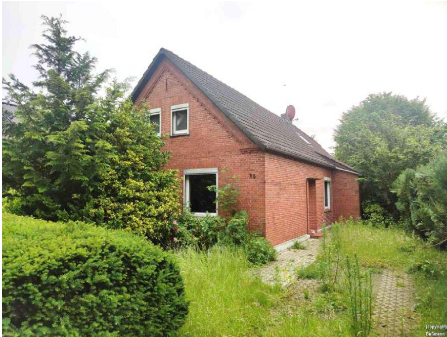
Frontansicht des Wohnhauses mit Haupteingang
