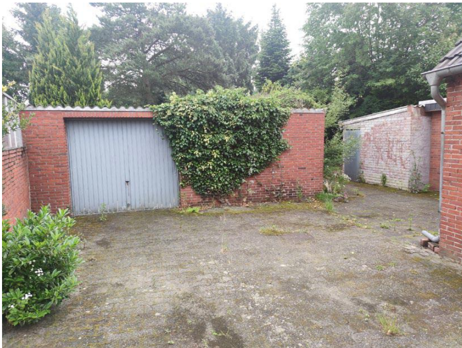
Garage und Nebengebäude im hinterem Hofbereich
