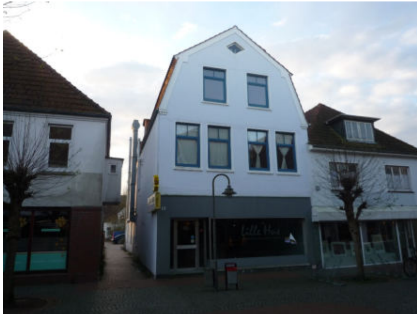
Wohn- und Geschäftshaus straßenseitig, Nordansicht
