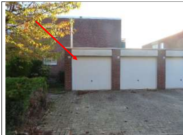
Ansicht von der Elsternstraße
