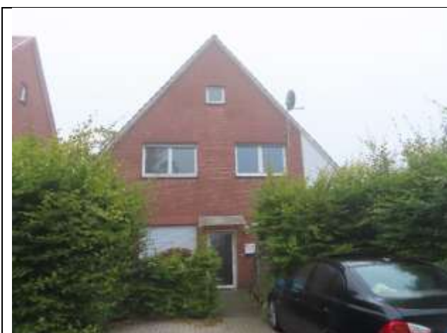
Eingang Wohnung EG Hausnr. 29
