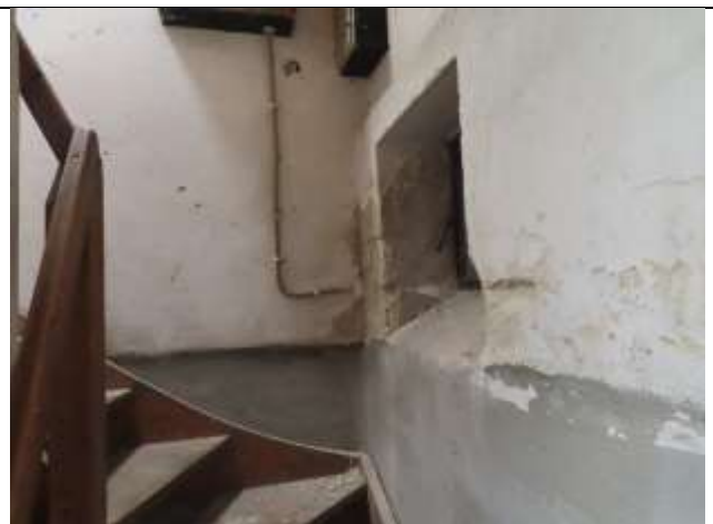
Treppe in den Keller
