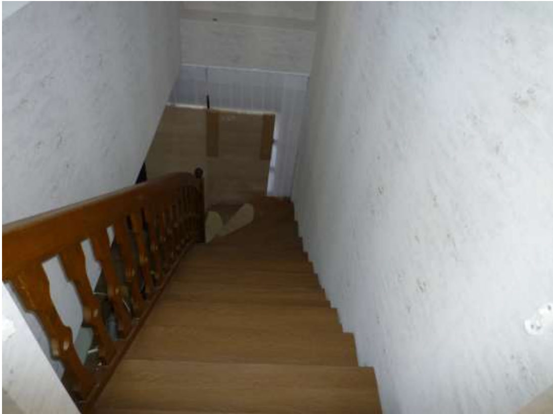
Geschosstreppe EG / DG
