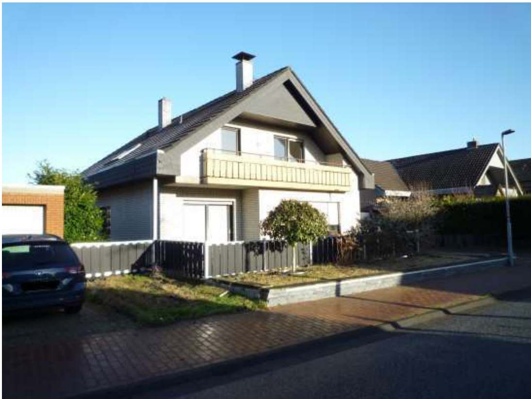
Frontansicht links Flurstück 24/312 / Ansicht aus südwestlicher Richtung
