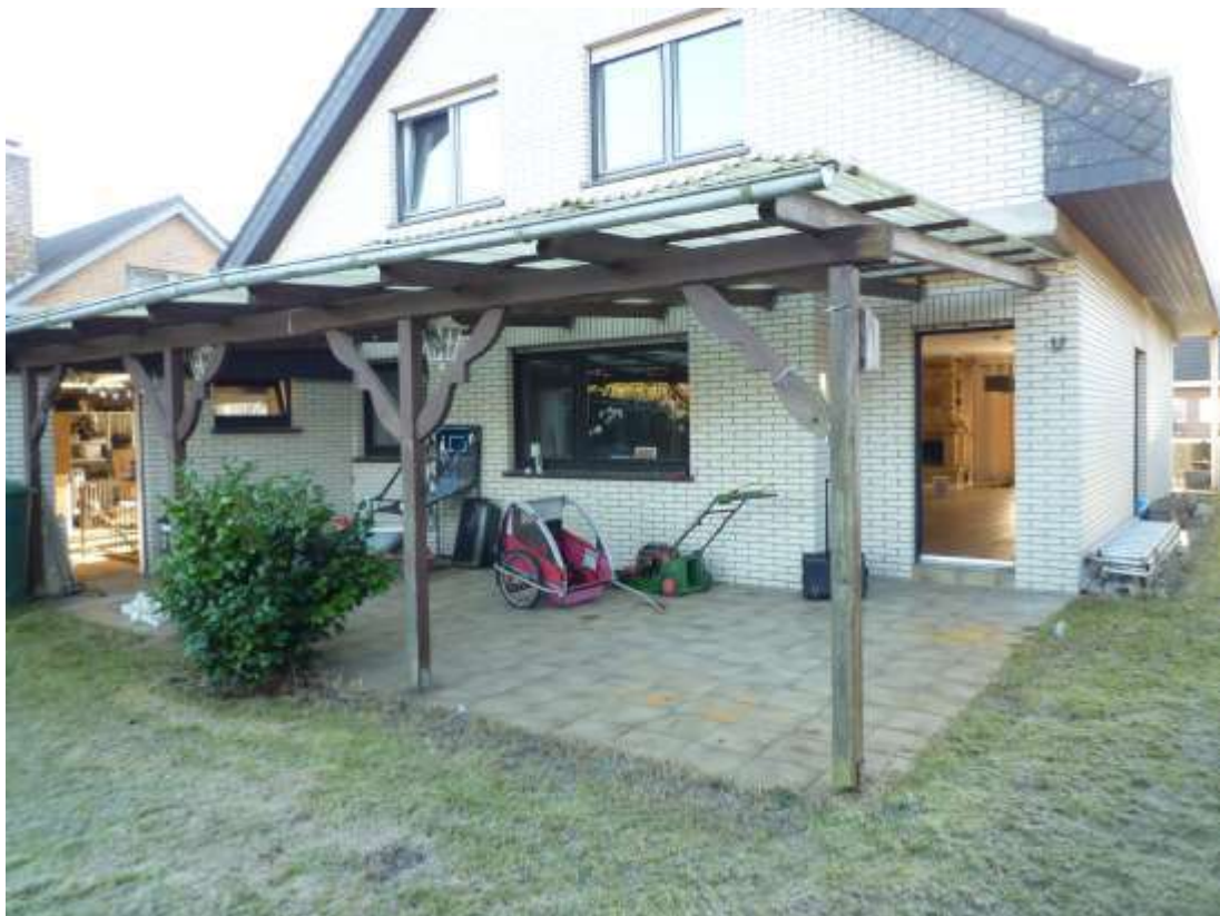
Terrasse / Terrassenüberdachung (nicht genehmigt) / Flurstück 24/312
