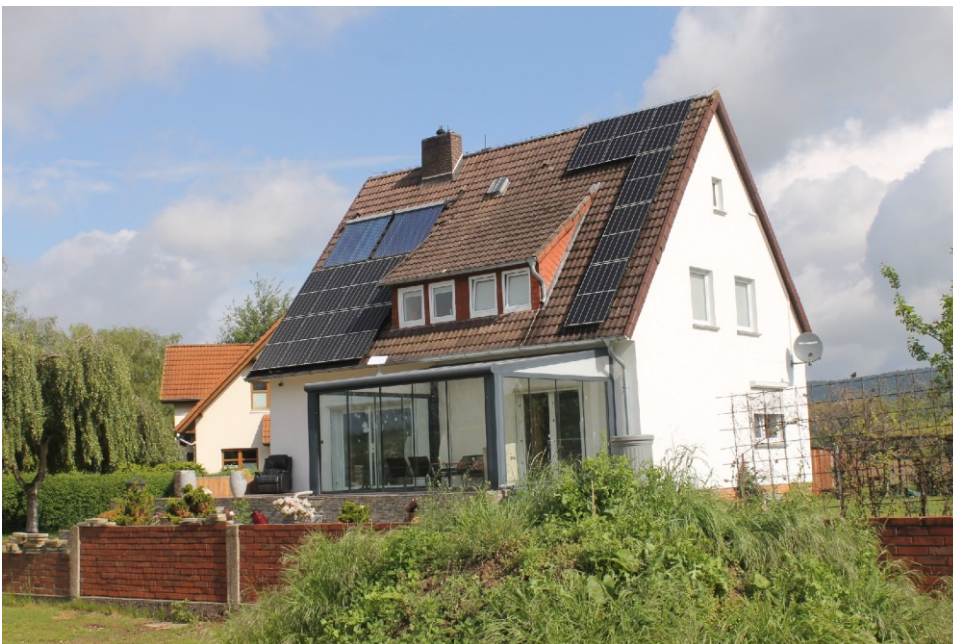
Ansicht des Bewertungsobjekts aus südöstlicher Richtung
