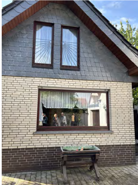
Ansicht Nord Anbau
