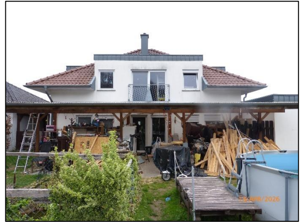
Südwestliche Ansicht (Terrassenüberdachung)
