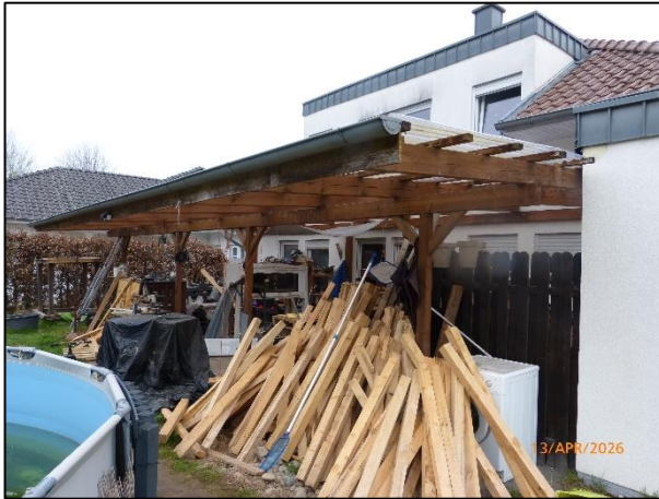
Südliche Ansicht (Terrassenüberdachung)
