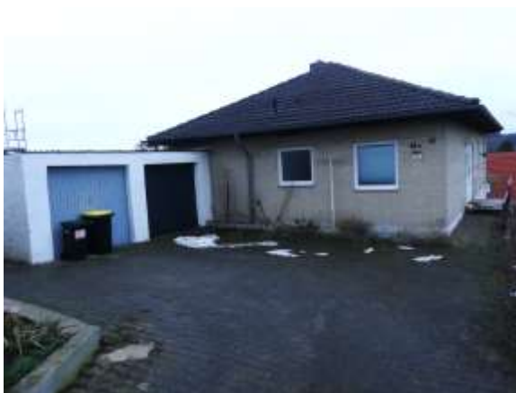
Südansicht Wohngebäude und Doppelgarage
