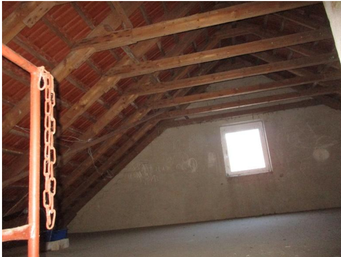
Blick auf den Dachboden
