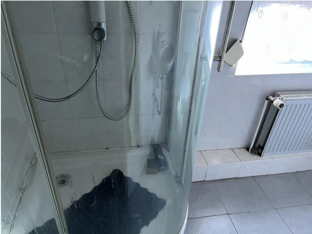
Bild 5: Bad im 2. OG
