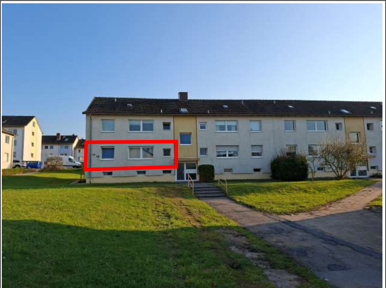
Ansicht von Norden mit der Zuwegung zum Wohnblock „Teichstraße 16“.
