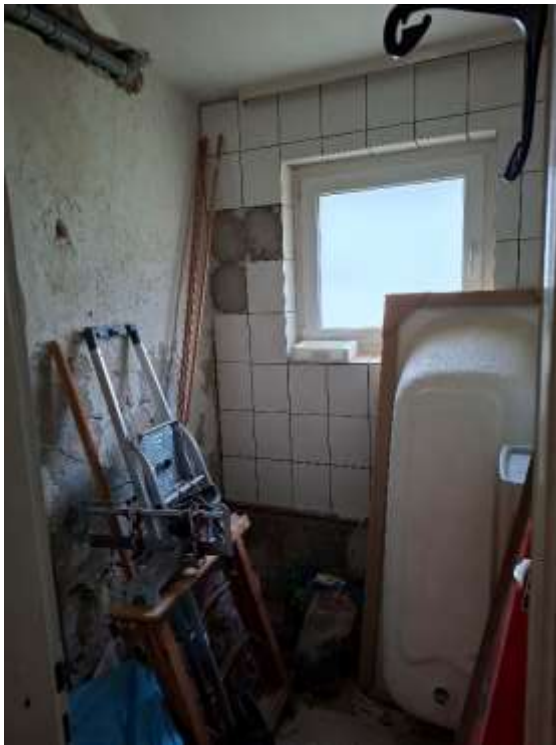
Bad im Rohbauzustand ohne Sanitärobjekte
