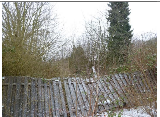
Ansicht Flurstück 32/97 von der Straße
