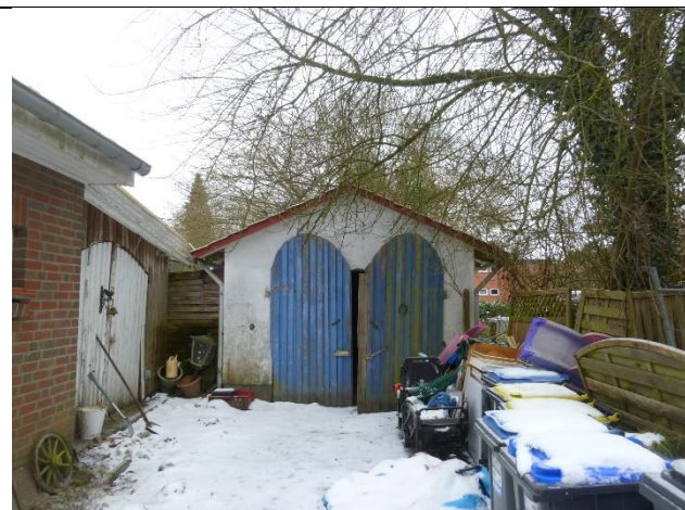
Ansicht Garage von der Einfahrt
