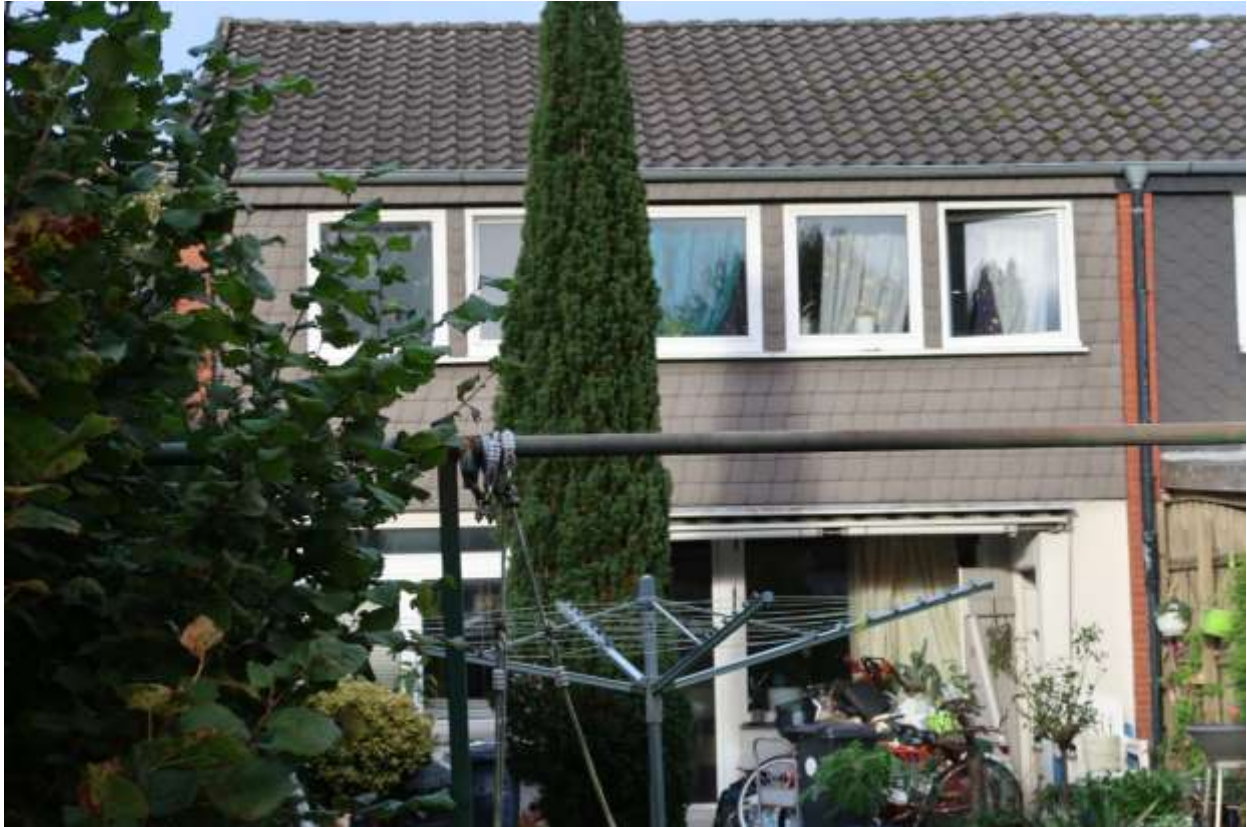
- Südwestansicht auf Flurstück 60/289 -
