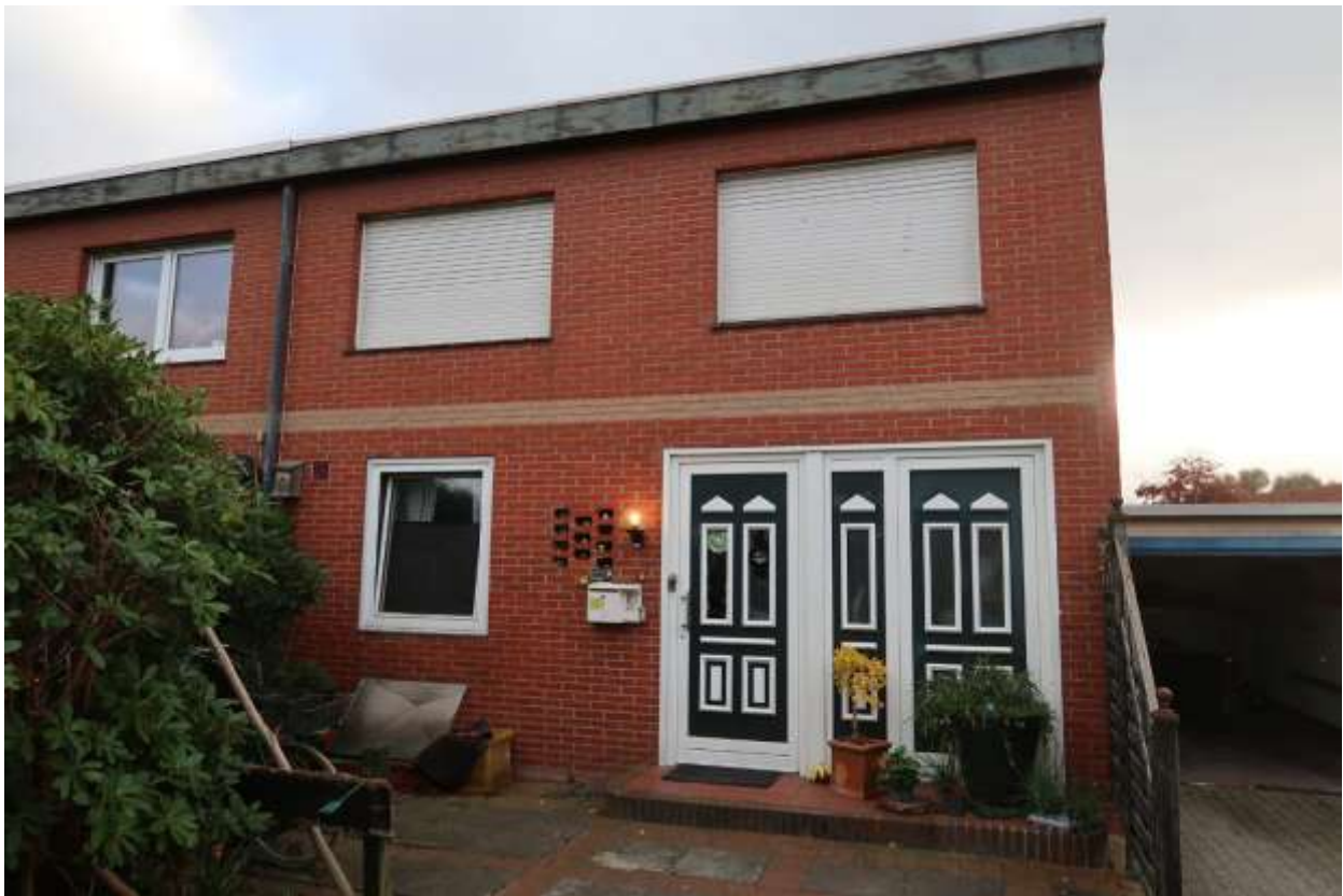
- Nordostansicht auf Flurstück 60/289 -
