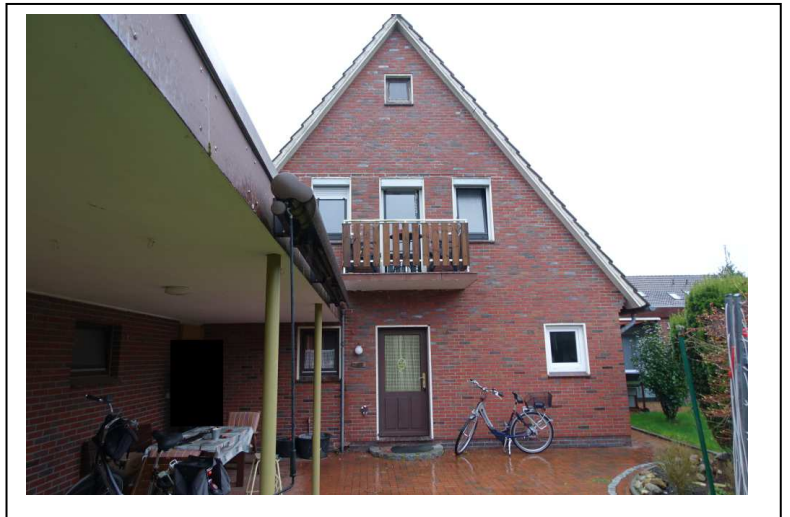
Ansicht aus nord-westlicher Richtung - von der Terrasse aus -
