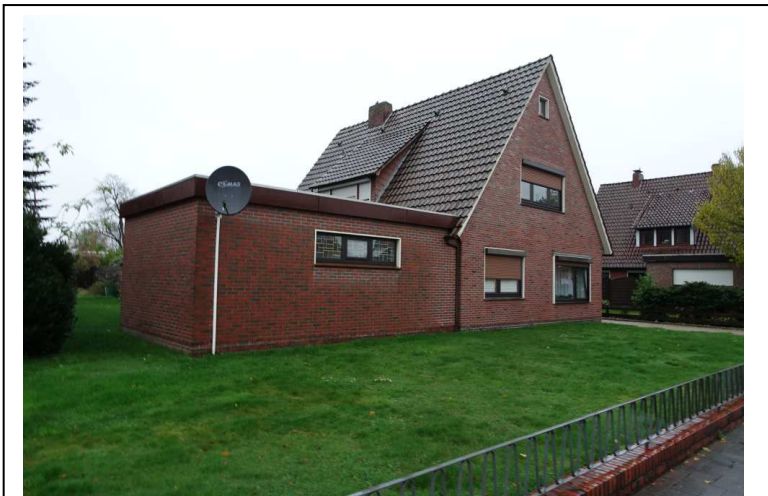
Straßenansicht aus süd-westlicher Richtung
