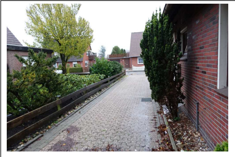
Die Auffahrt ist mit Betonsteinen ausgelegt.
