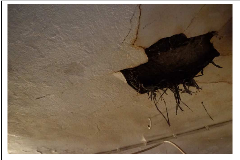
Ansichten der Unterseite des Garagendaches
