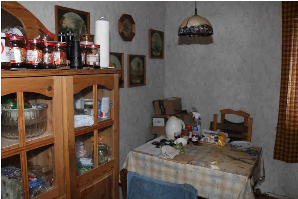
Küche im Erdgeschoss (Exemplarischer Zustand des Gebäudes)
