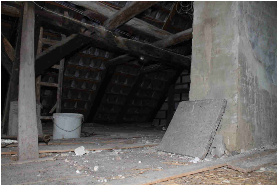
Nicht ausgebauter Dachraum
