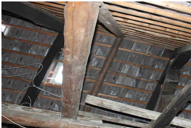
Nicht ausgebauter Dachraum
