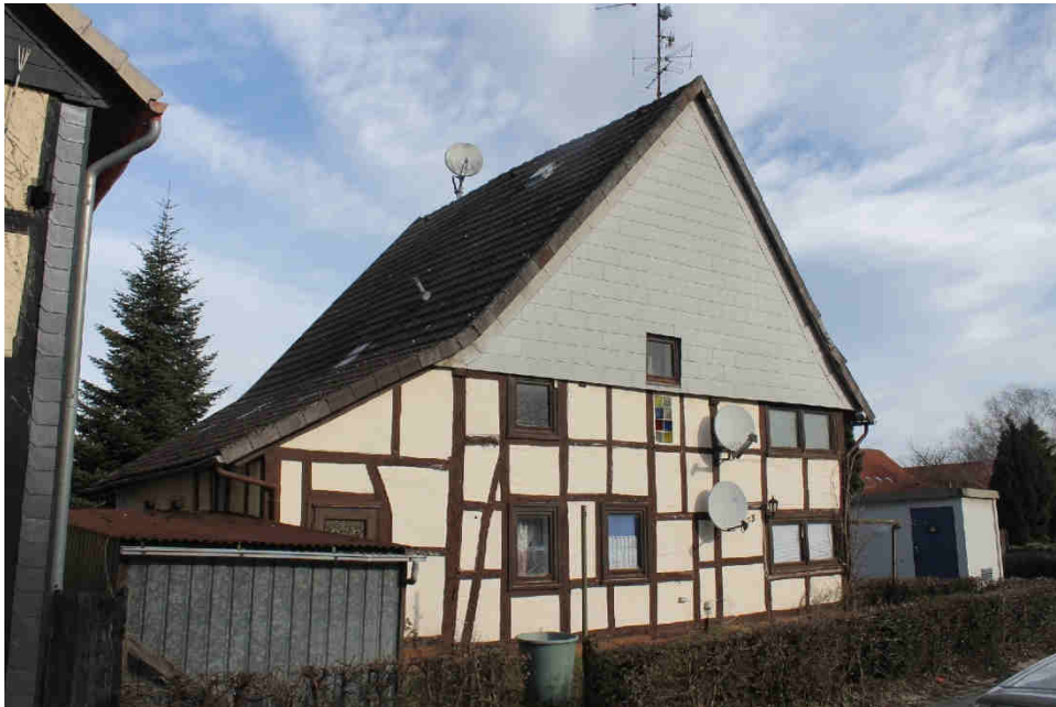
Ansicht des Bewertungsobjekts aus südlicher Richtung
