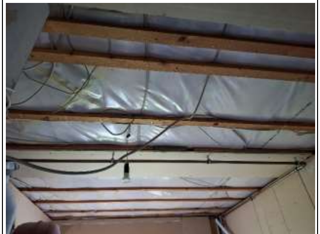
HAR / Heizungsraum: offene Elektrokabelinstallation und fehlende Gipskartonbauplatten an Wand und Decke
