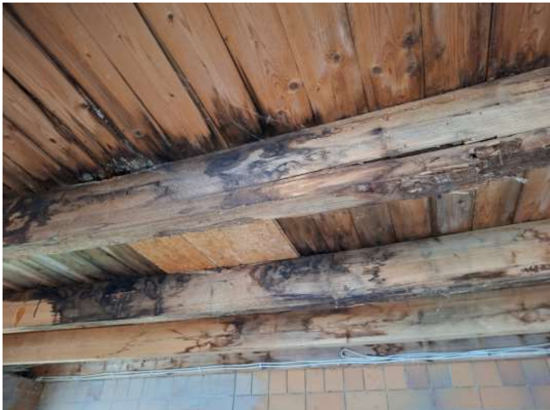
Schadhafte, sich stark durchbiegende und teilweise eingerissene und durchgebrochene Dachsparren in der Garage, nach Schaden an der Dachabdichtung
