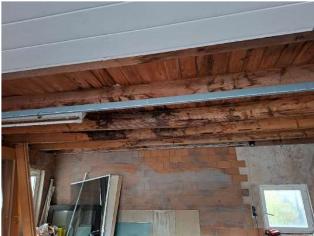
Schadhafte, sich stark durchbiegende und teilweise eingerissene und durchgebrochene Dachsparren in der Garage, nach Schaden an der Dachabdichtung
