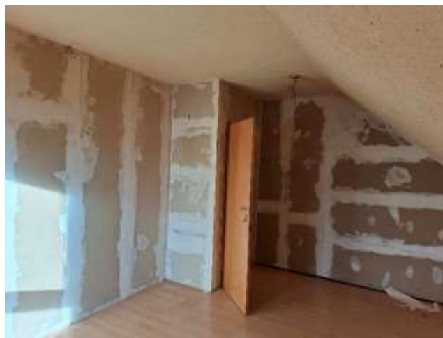
DG: Rohe Gipskartonbauplatten an der Trennwand zu Zimmer 2 u. zur Empore im Zimmer 1
