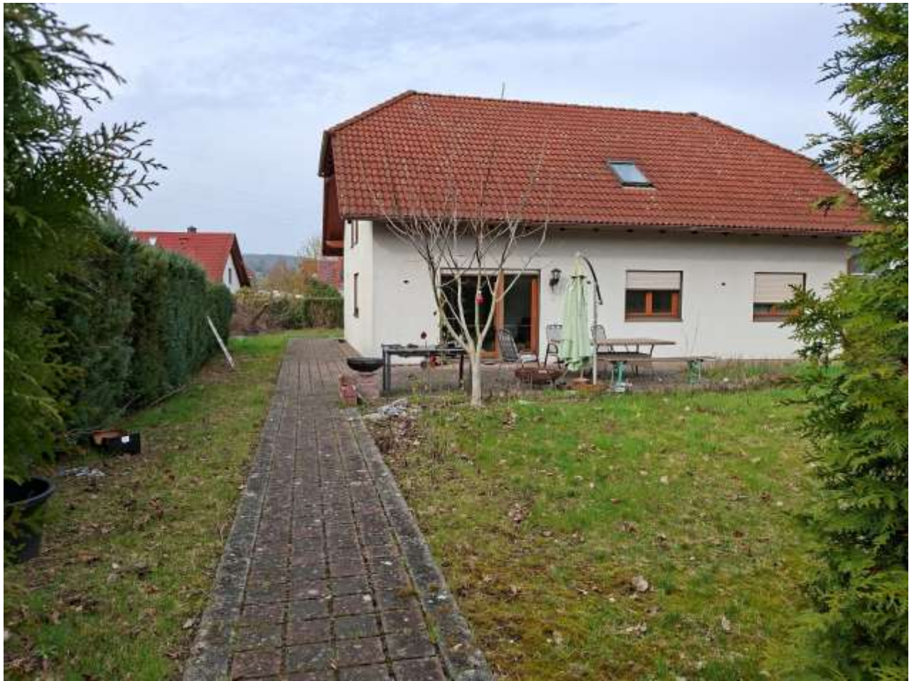
Ansicht von Süden mit der Zuwegung zum Hauseingang
