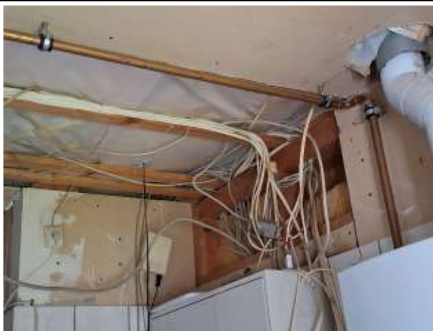
HAR / Heizungsraum: offene Elektrokabelinstallation und fehlende Gipskartonbauplatten an Wand und Decke
