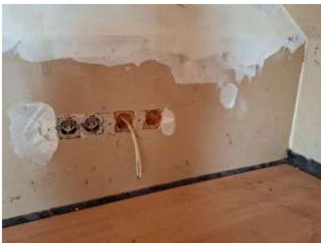
Auf der Empore und in den Zimmern 1 und 2 des Dachgeschosses fehlen die Abdeckungen der Schalter und Steckdosen
