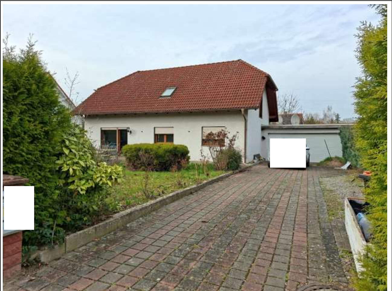
Ansicht von Süden mit der Auffahrt zur Doppelgarage
