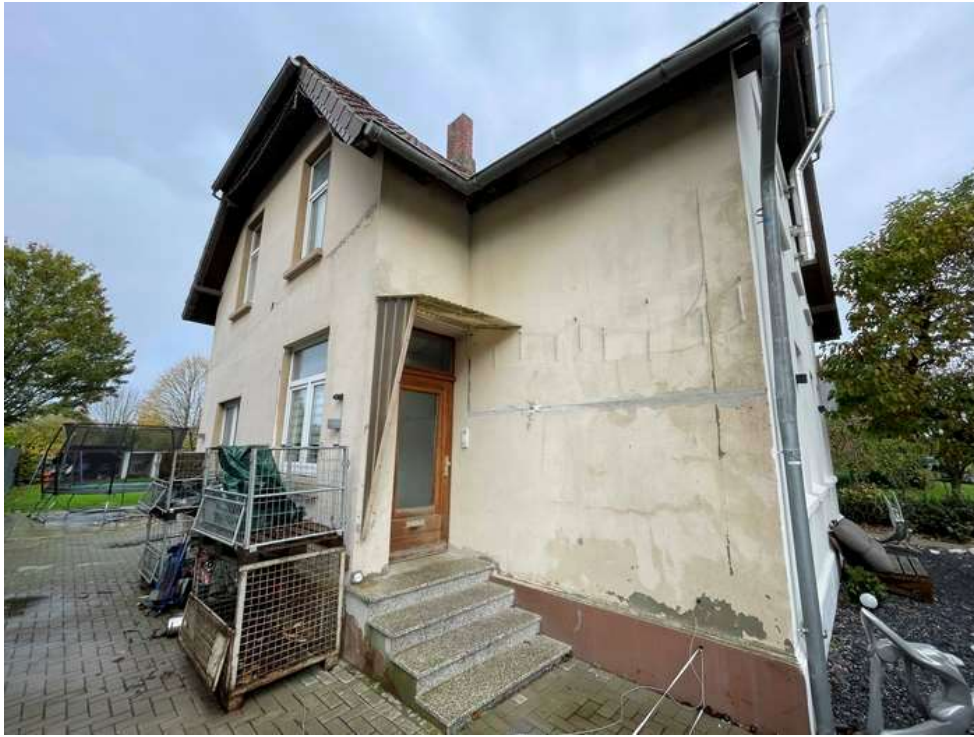
Bild 3 - Fährstraße 54, 26954 Nordenham - Außenansichten
