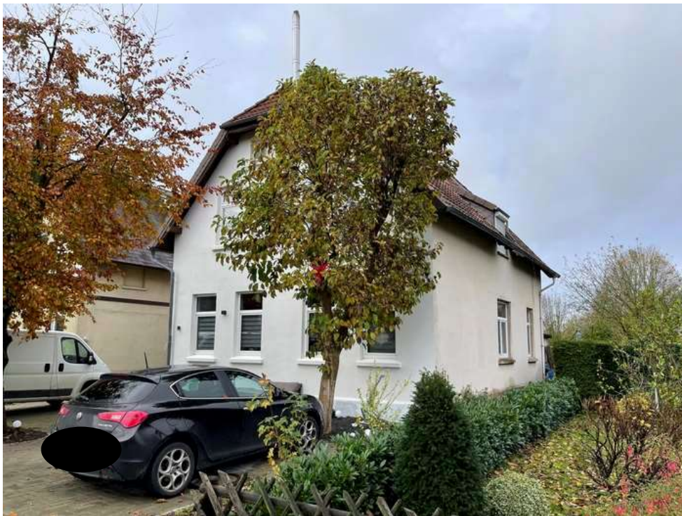
Bild 2 - Fährstraße 54, 26954 Nordenham - Außenansichten
