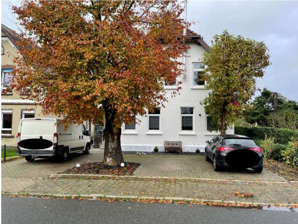
Bild 1 - Fährstraße 54, 26954 Nordenham - Außenansichten
