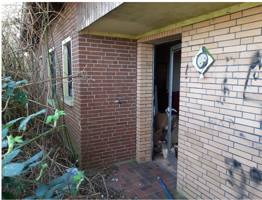
Bild: 3/5 Ansicht Eingangsbereich.
