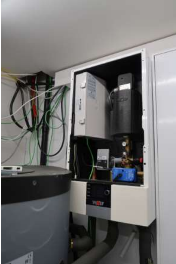
- Erdgeschoss Heizungsanlage Wärmepumpe -
