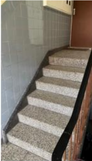
Treppenhaus Richtung 1. Obergeschoss
