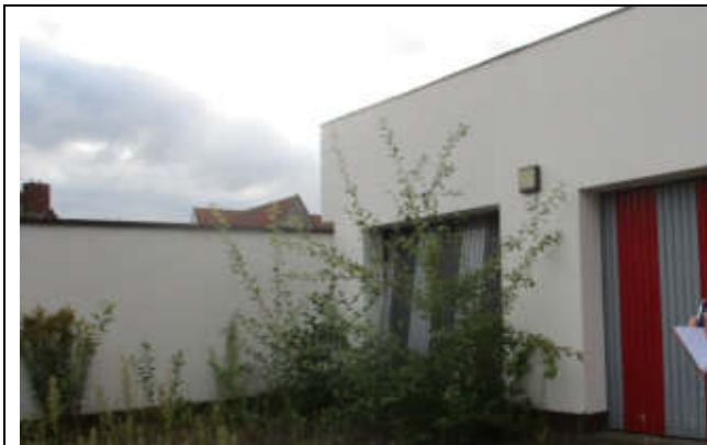
Ansicht von Nordwest
