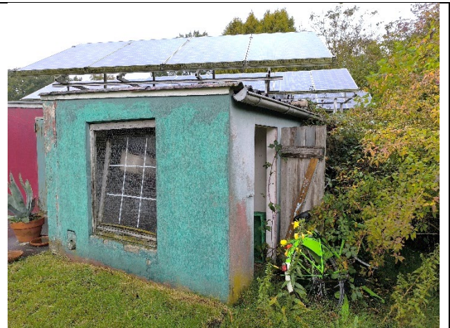
Ansicht Nebengebäudes von Süden
